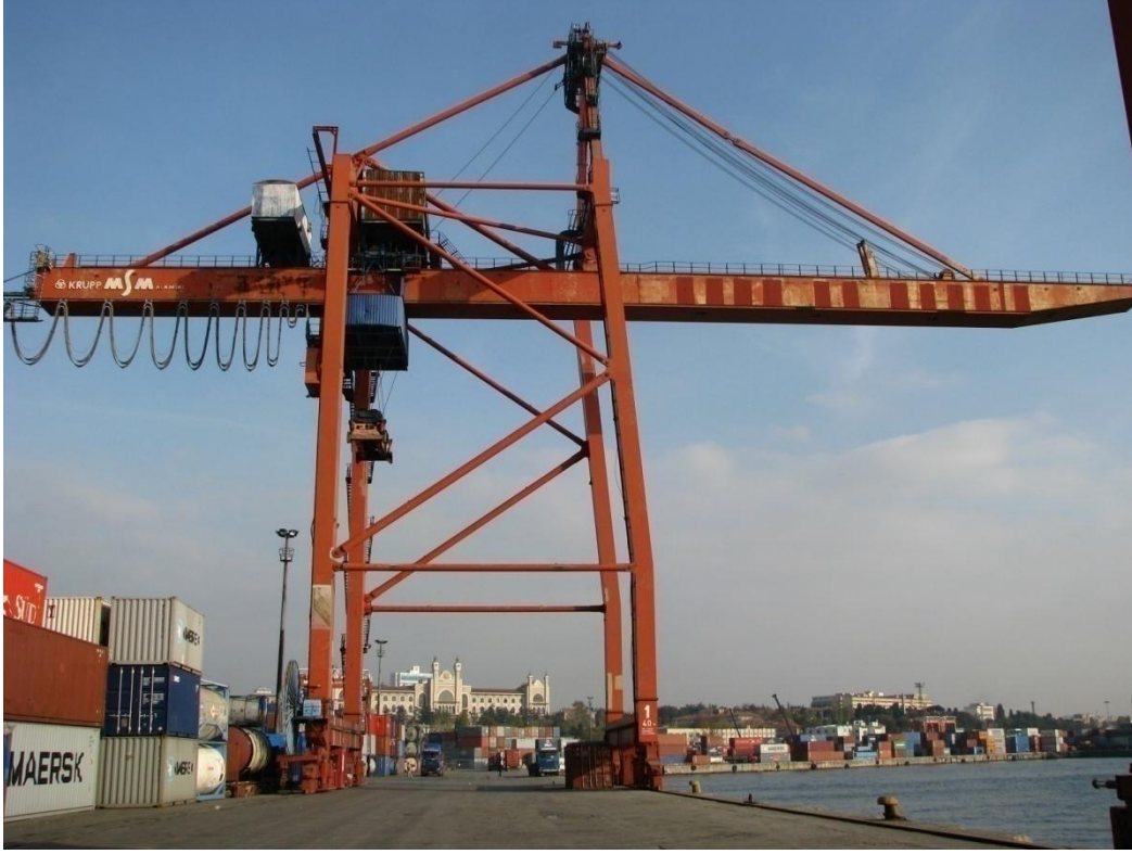
Şekil 1.4 : Limanlarda konteyner elleçlemede kullanılan kren (gantry crane).
