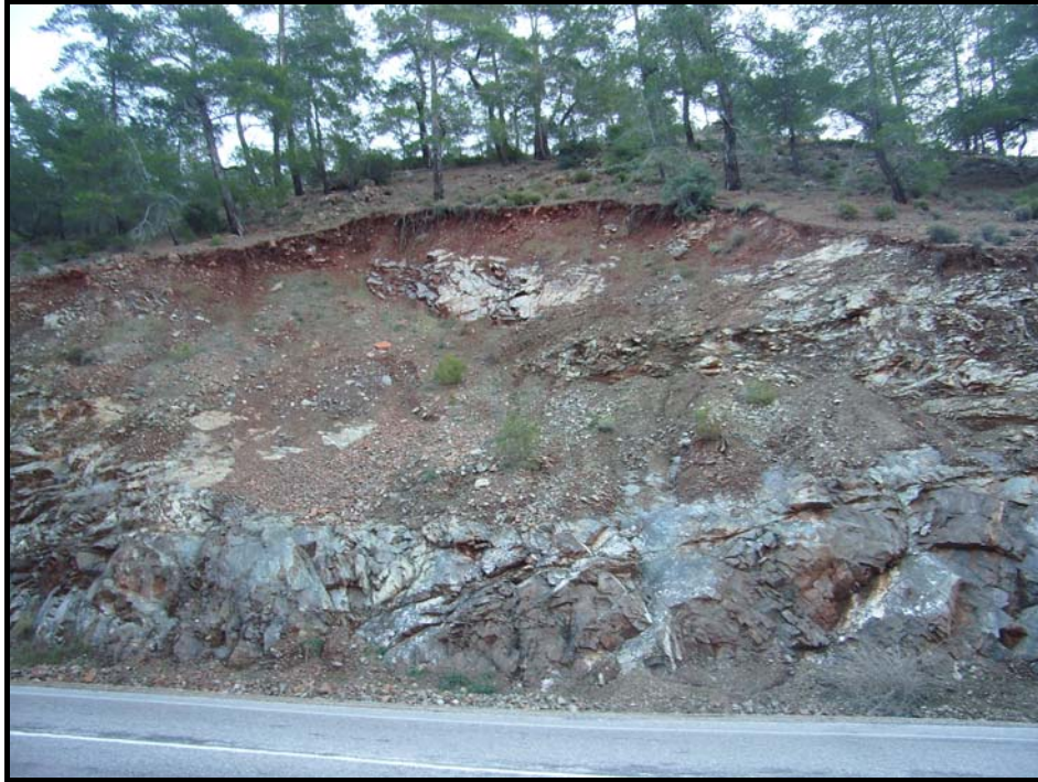
Foto 74 :eri Deresi vadisinde meydana gelmiř bir mini heyelan y zeyi
