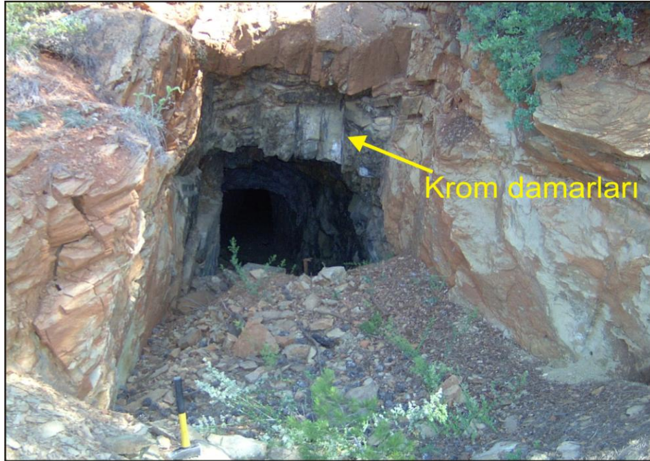
Şekil 4.26: Kromit bantları boyunca açılan galeri [70774/29157].
