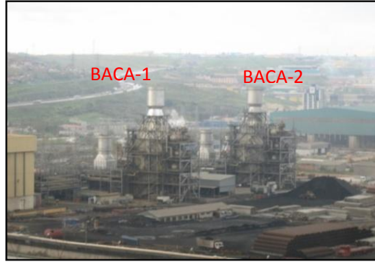
Şekil 3.11 : OVA A.Ş.’ ye ait atık ısı kazan bacaları (Emisyon Kaynağı)
