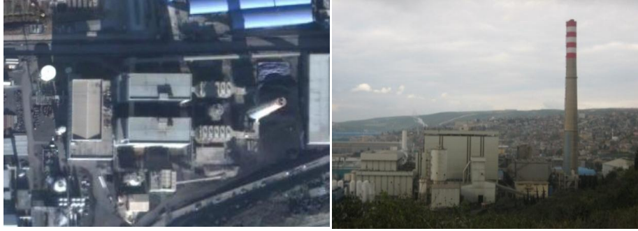
Şekil 3.12 : Çolakoğlu OP2 enerji santrali
