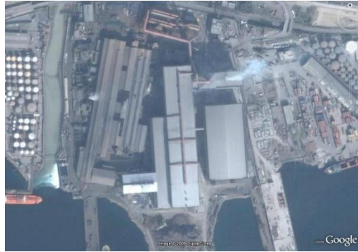
Şekil 3.13 : Çolakoğlu Metalurji A.Ş. Demir-Çelik Tesisi uydu görüntüsü
