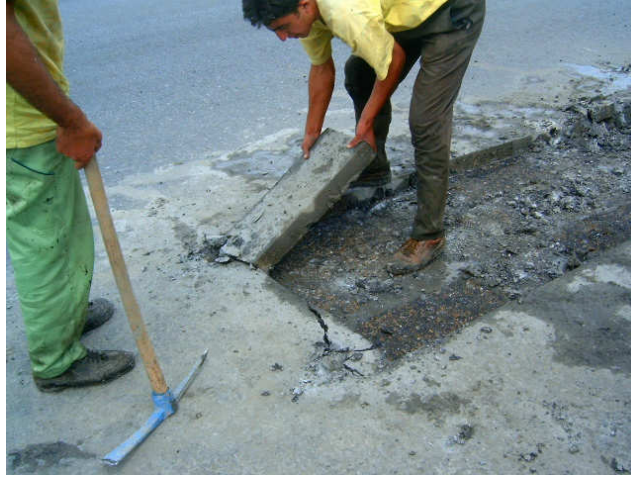
Şekil 3.10: Kesilen plakların tahrip edilmeden alınması (TMA)
