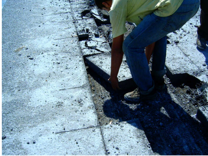
Şekil 3.17: Kesilen plakların tahrip edilmeden alınması (Modifiye)
