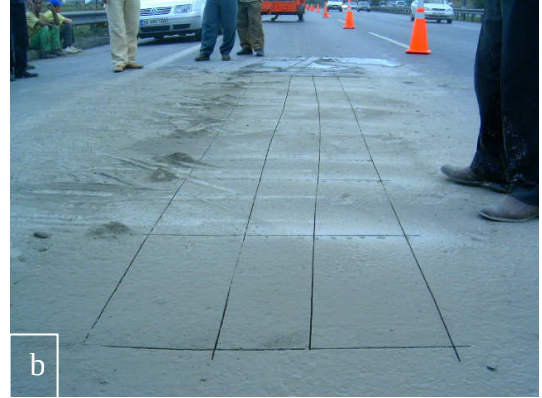
Şekil 3.8.a,b: Kesilecek kısımların yol üzerinde işaretlenmesi (TMA)
