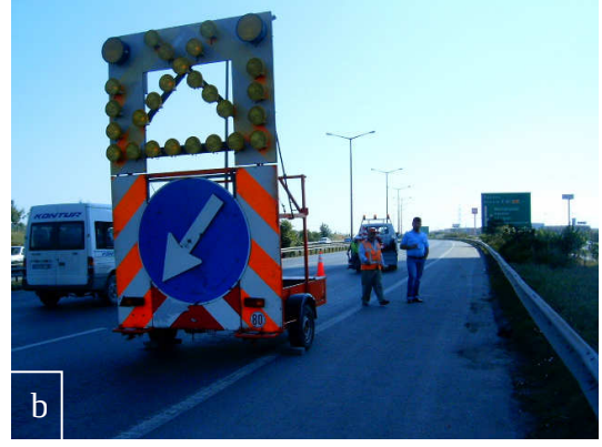
Şekil 3.7.a,b: Uygun trafik işaretleriyle sağ şeridin trafiğe kapatılması (TMA)
