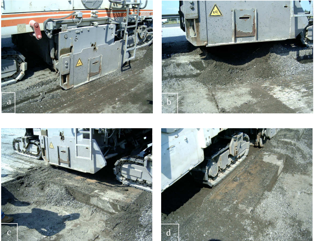
Şekil 3.2.a,b,c,d: Kemirici makina ile blok kenarlarının zayıflatılması
