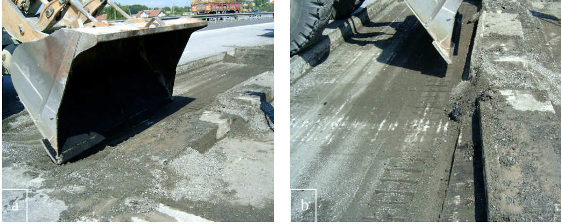
Şekil 3.3.a,b: Blokların tahrip edilmeden kaldırılması
