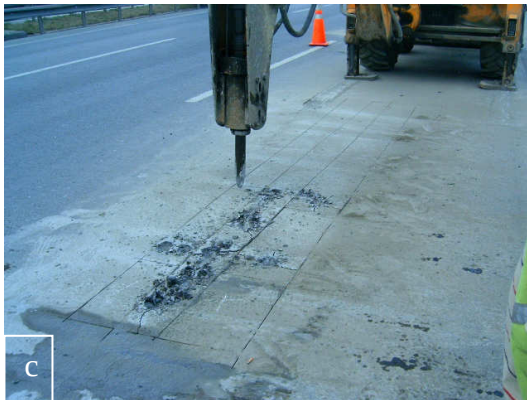
Şekil 3.9.a,b,c,d: Plakların kesilmesi ve kenarlarının zayıflatılması (TMA)
