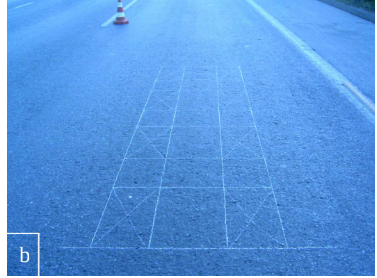
Şekil 3.8.a,b: Kesilecek kısımların yol üzerinde işaretlenmesi (TMA)
