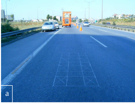
Şekil 3.8.a,b: Kesilecek kısımların yol üzerinde işaretlenmesi (TMA)
