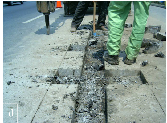
Şekil 3.9.a,b,c,d: Plakların kesilmesi ve kenarlarının zayıflatılması (TMA)
