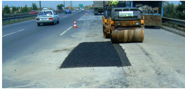
Şekil 3.13: Yapılan yamanın sıkıştırılması (TMA)
