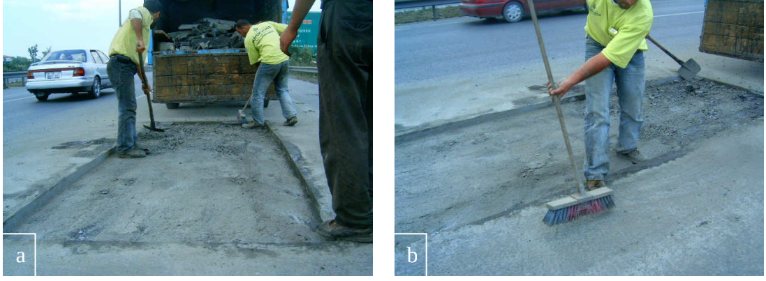
Şekil 3.12.a,b: Numune alınan kısımların boşaltılıp temizlenmesi (TMA)
