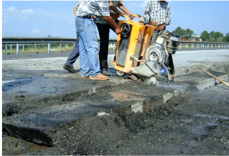
Şekil 3.4: Blokların asfalt kesme makinası ile kesilmesi
