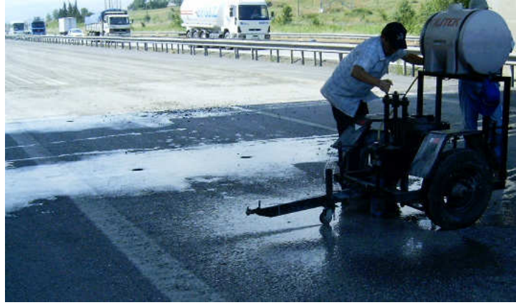
Şekil 3.6: Aşınma ve binder karotlarının alınması
