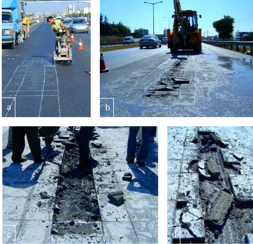
Şekil 3.16.a,b,c,d: Plakların kesilmesi ve kenarlarının zayıflatılması (Modifiye)
