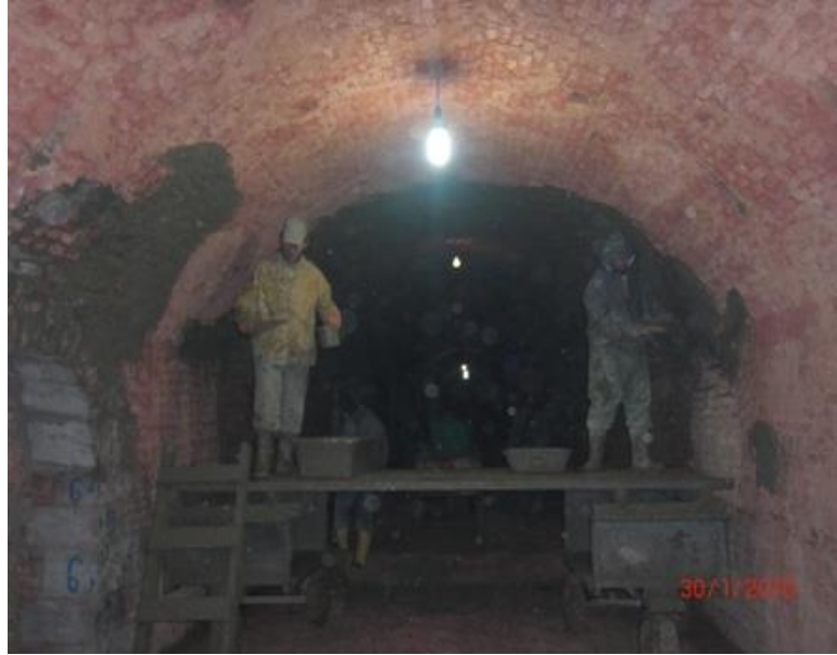
Şekil 3.12 Bay-Kes fabrikası Hoffman fırınının içi [32].
