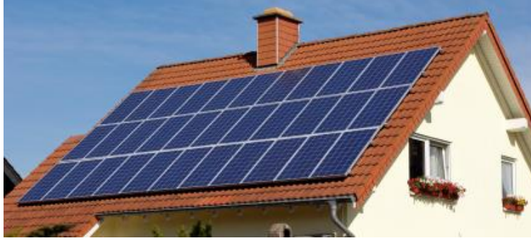
Şekil 2.12: Eğimli bir çatıya kurulmuş güneş panel sistemi.
