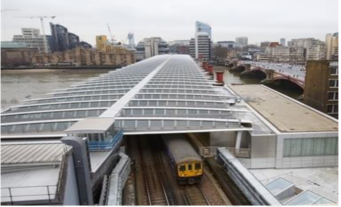
Şekil 2.11: Londra’da elektrik üreten güneş panellerine sahip Blackfriars Köprüsü.
