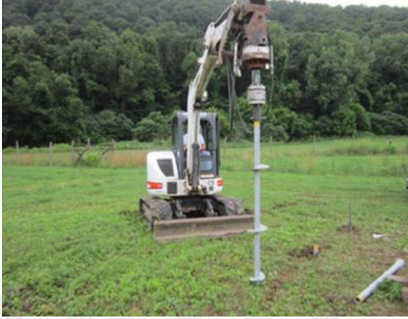
Şekil 2.21: Helisel kazık imalatı.
