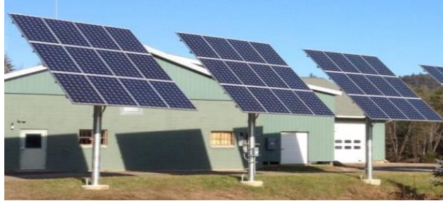
Şekil 2.16: Güneş panellerinde kullanılan yerinde dökme kazıkar (Lutenegger, 2016).
