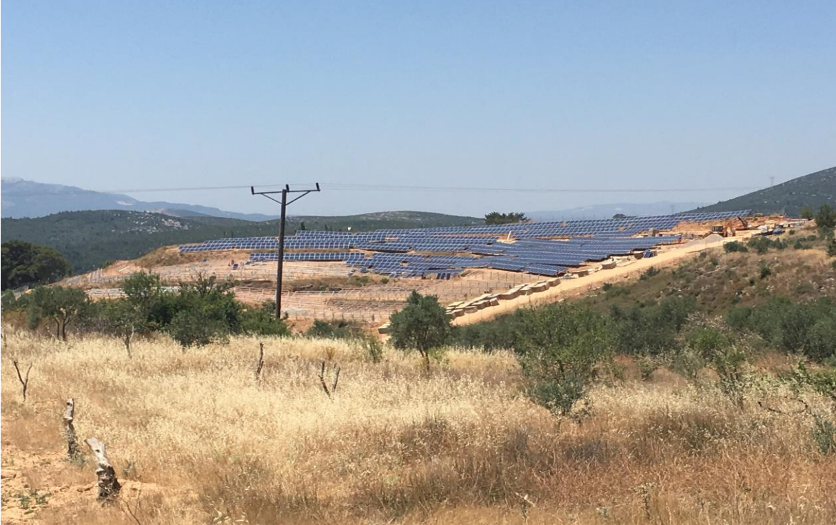
Şekil 4.7. A işyerine ait panel montaj işlemi
