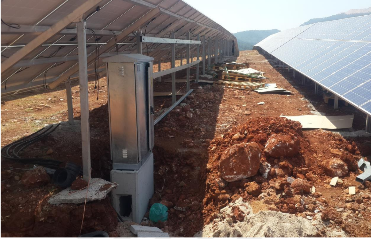
Şekil 4.8. B işyerine ait kablo montaj işlemi
