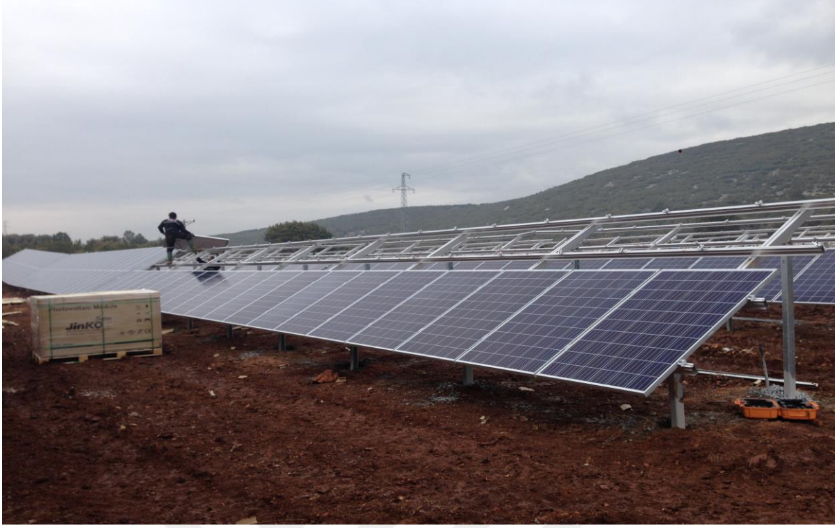
Şekil 4.6 C işyerine ait panel montaj işlemi
