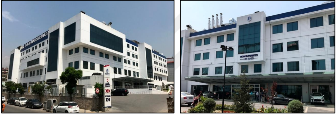
Şekil 5.115 Okan Üniversitesi Hastanesi-Güncel dış cephe görüşleri [154]
