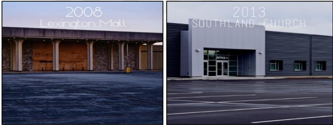
Şekil 5.10 Yapının özgün ve dönüşümden sonraki cephe görünüşü [107]
