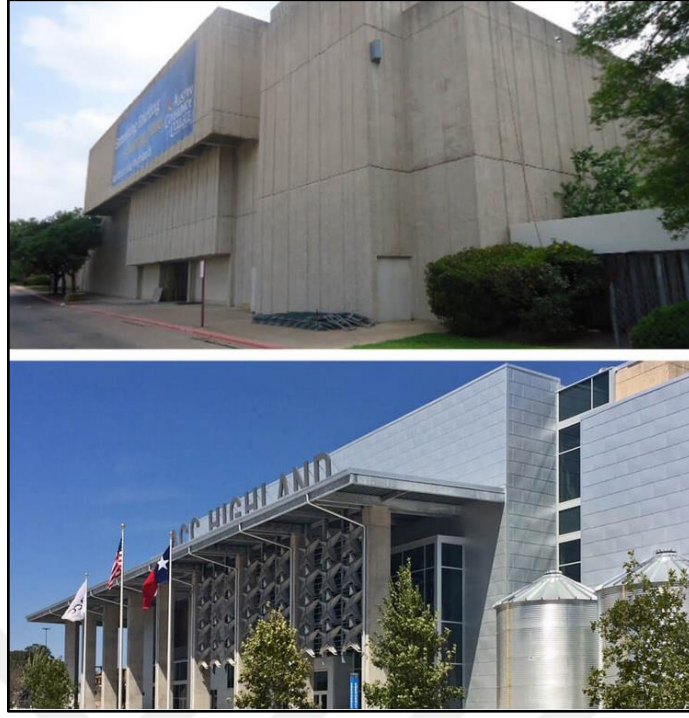
Şekil 5.37 Austin College-Özgün ve yeni cephe görünüşleri [119]
