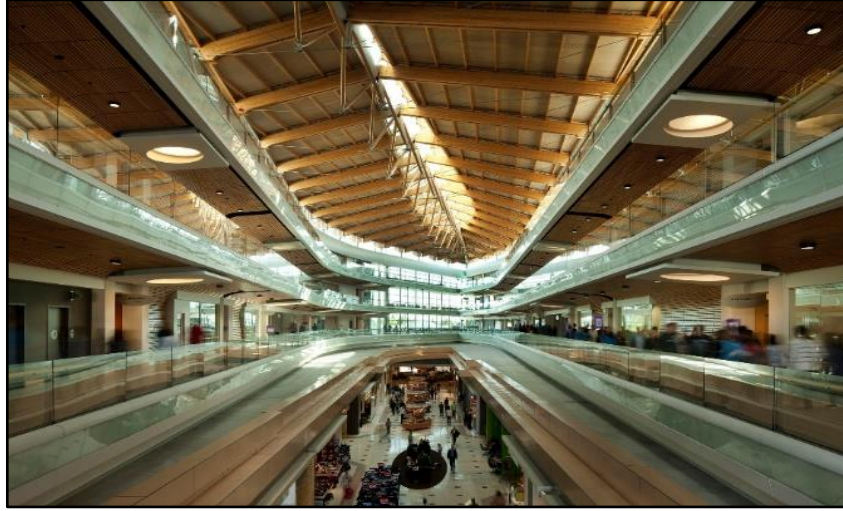
Şekil 5.56 SFU Surrey Campus-Yeni ahşap-metal çatı ve iç mekân [129]
