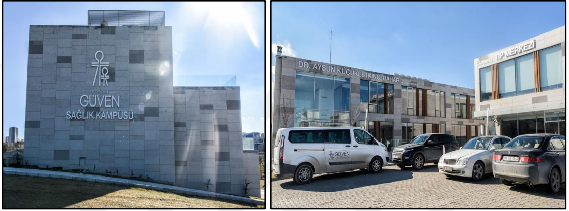
Şekil 5.121 Güven Tıp Merkezi-Güncel dış cephe görüşleri [156],[157]
