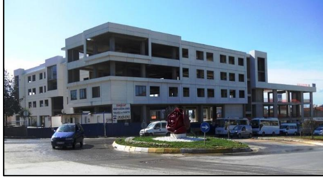
Şekil 5.112 Pekintaş AVM- İnşaatı yarım kalan yapı [155]
