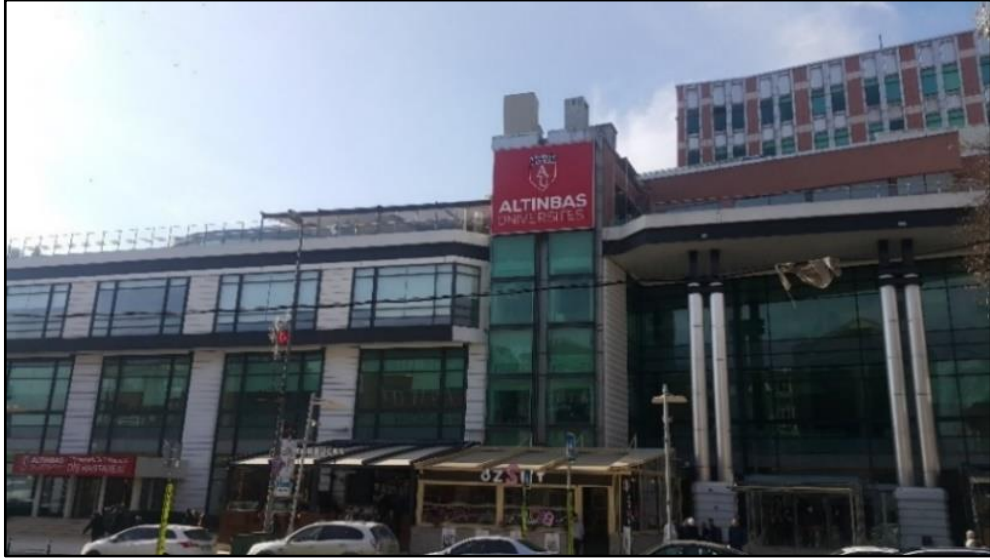
Şekil 5.80 Altınbaş Üniversitesi-Güncel dış cephe görünüşü
