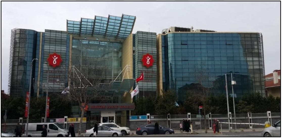
Şekil 5.90 Birikim Koleji-Güncel dış cephe görünüşü
