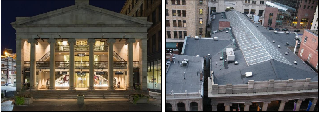
Şekil 5.12 The Providence Arcade-Ön cephe ve çatı ışıklığı [110]
