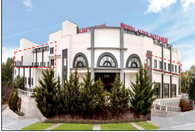
Şekil 5.125 Minaseri Hastanesi-Güncel cephe görünüşü ve eklenen pencereler [161]
