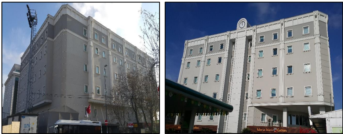
Şekil 5.100 IAU Yurt Binası-Güncel dış cephe görünüşü
