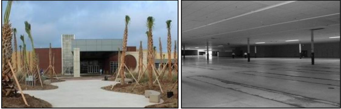
Şekil 5.18 Texas Walmart-Yapının özgün iç-dış mekân görünüşleri [112], [113]
