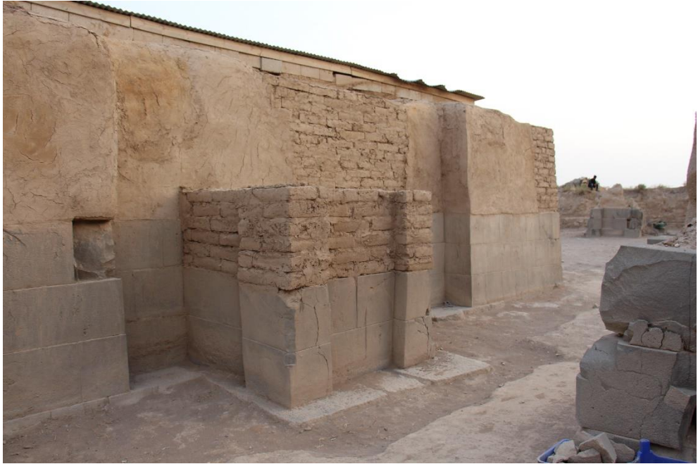
Resim 21. Cella Kuzey Duvarı, Bazalt ve Kerpiç Duvarlar
