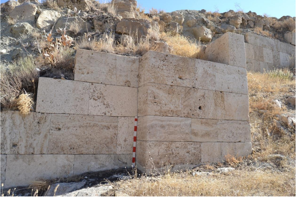
Resim 3. Çavuştepe Uçkale Yöntemi Sur Duvarları Örneği (Rıfat Kuvanç 2017)
