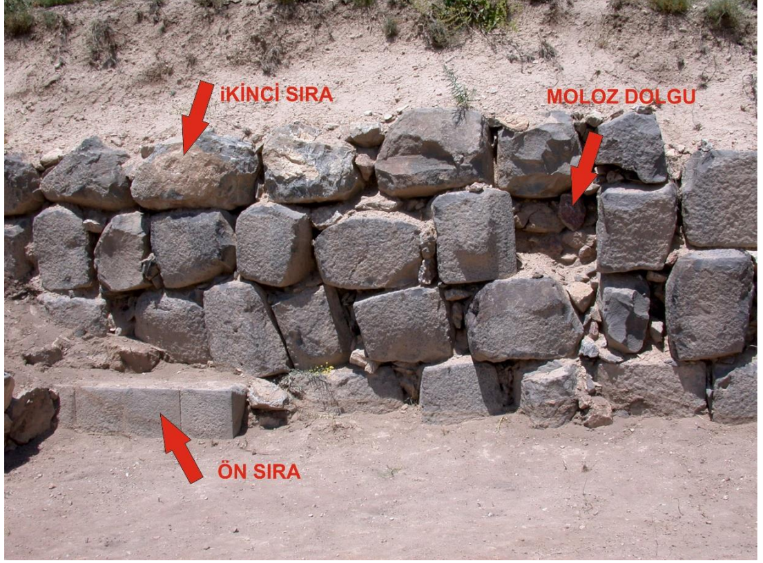
Resim 13. Güney Sur Alanı Sandık Duvar Tekniği
