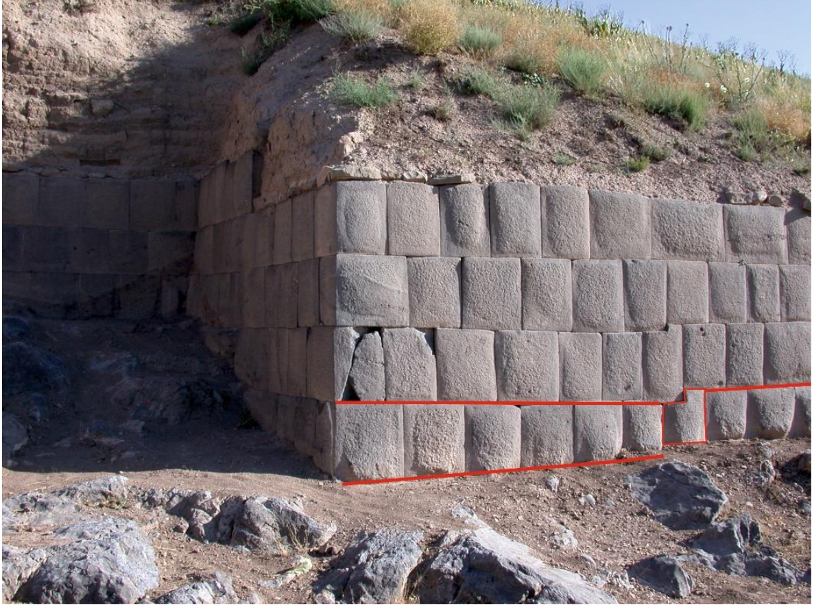
Resim 12. Güney Sur Alanında Eklemlı Blok Kullanımı
