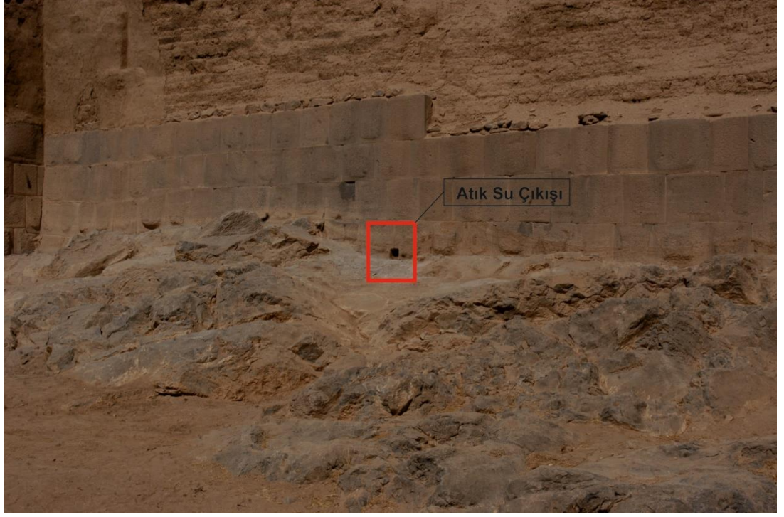
Resim 31. Güney Sur Alanı Atık Su Kanalı Çıkışı
