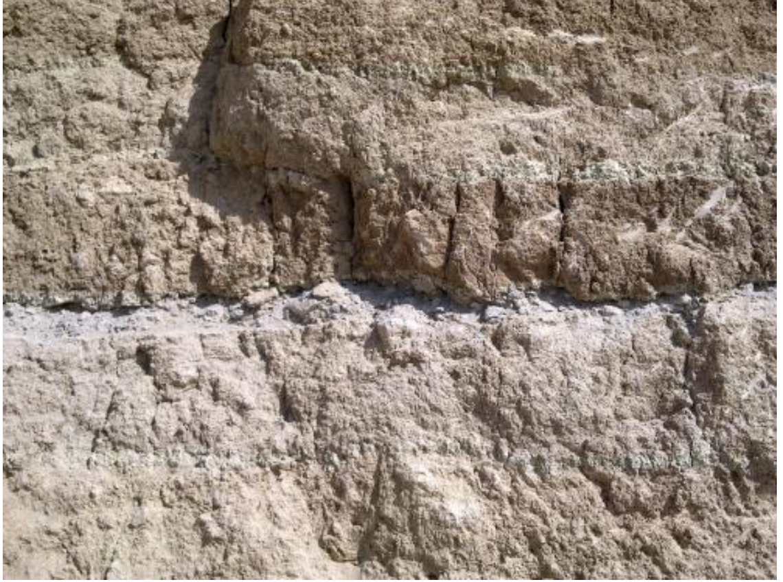
Resim 16. Güney Sur Alanında Kerpiç Blokları Arasında Yer Alan Mıdır Tabakası
