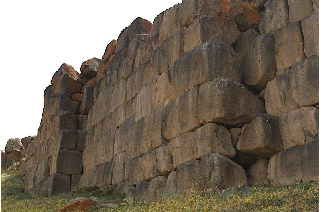
Resim 2. Körzüt Kalesi Kuzey Sur Duvarları Klasik Urartu Yöntemi
