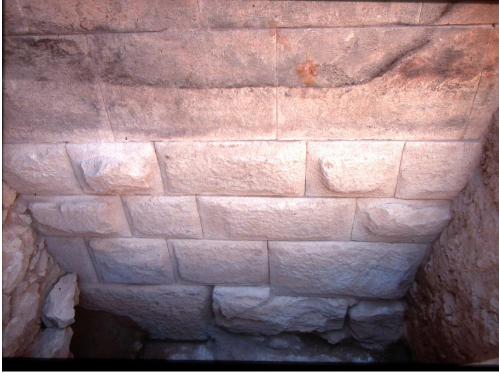
Resim 22. Cella Temellerinden Kesit
