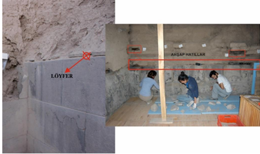
Resim 23. Cella'da Löyfer ve Ahşap Hatıl Kullanımı
