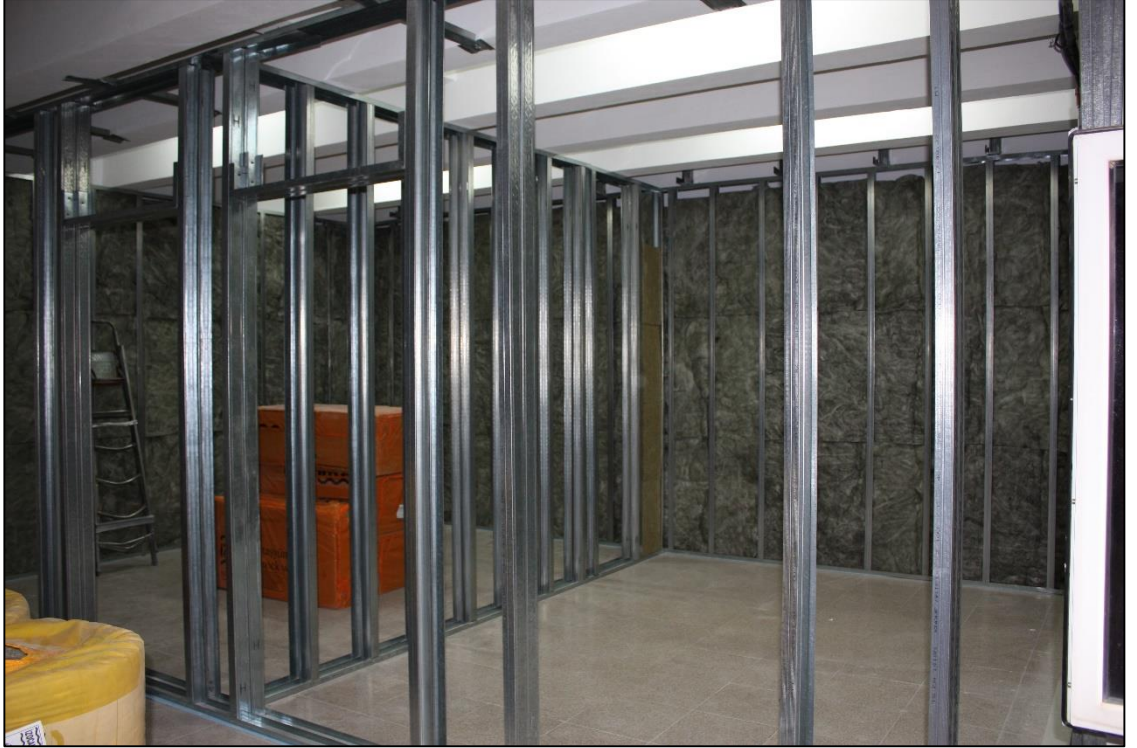
Şekil 3.20. e-Stüdyo imalat süreci (taşyün, camyün, alçıpan kaplama)
