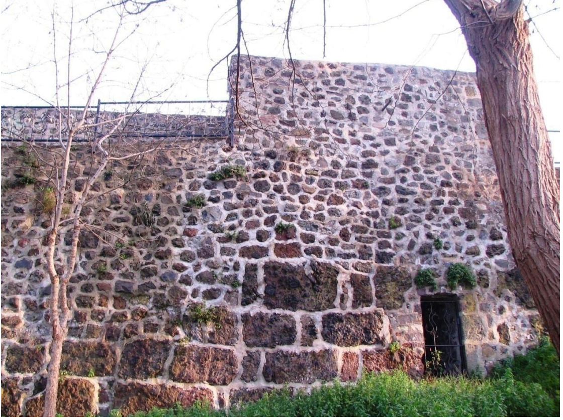
Fig.235 İç kaledeki Roma Dönemi duvar örgüsünden görünüm.
