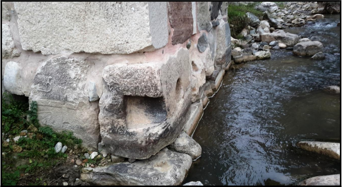
Fig.60 Kurt Köprü'nün ayak köşe kısmında devşirme olarak kullanılan ağırlık taşları.
