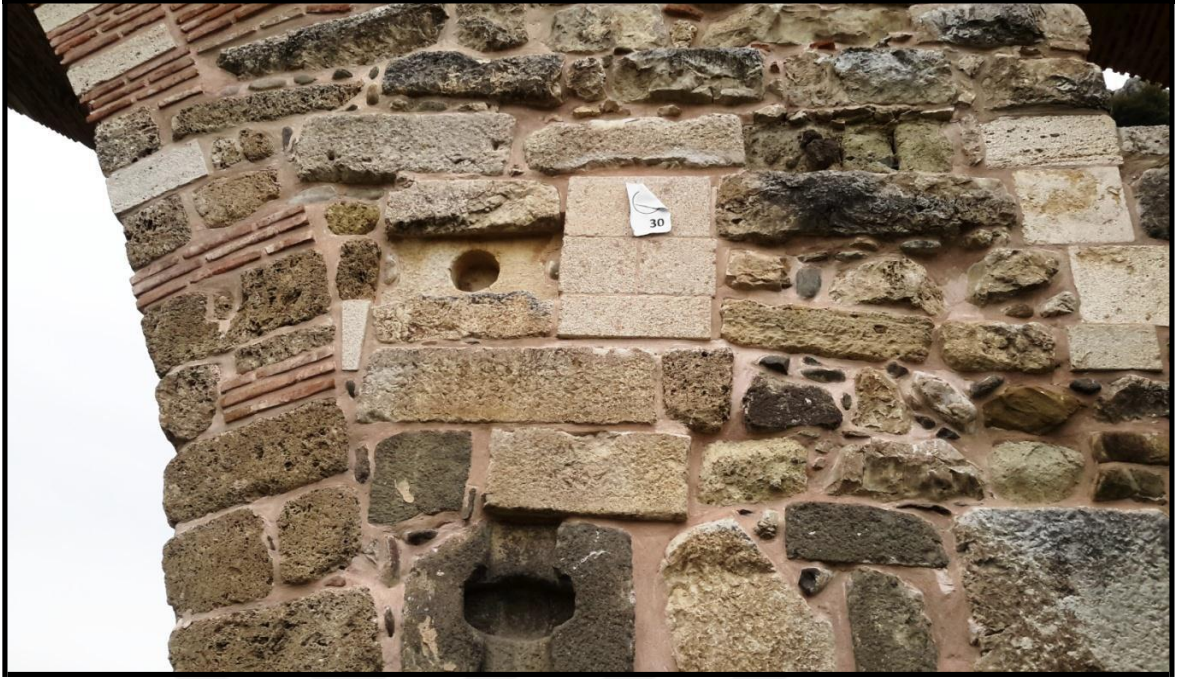
Fig.59 Kurt Köprü'nün kemerinde devşirme olarak kullanılan ağırlık taşları.
