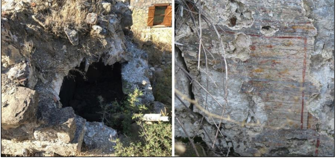
Şekil 3. 38 543 Ada 2 Parselde yer alan hamam kalıntısı ve duvarlarındaki süslemeler [E. Alyakut, 2017]
