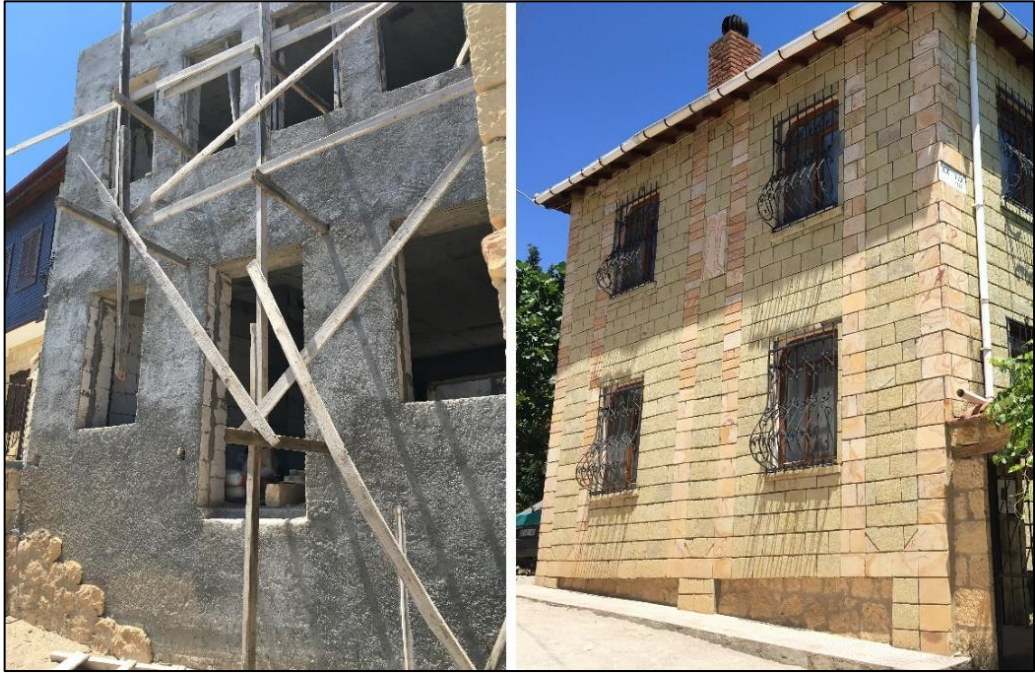
Şekil 5. 9 Yeşilyurt köyünde inşa edilmiş olan dokuyla uyumsuz yeni yapılar [E. Alyakut, 2017]
