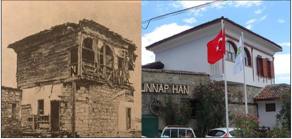
Şekil 3. 29 Konağın kuzey ve doğu cephelerinin 1977 ve 2017 yıllarındaki durumu [82], [E. Alyakut, 2017]
