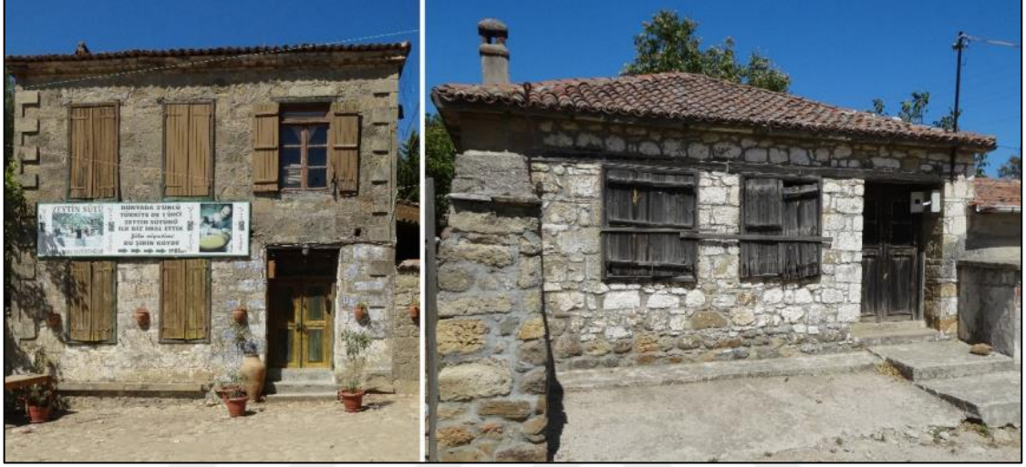
Şekil 5. 6 Basit onarım önerilen 1 ve 30 envanter no'lu yapılar [E. Alyakut, 2017]
