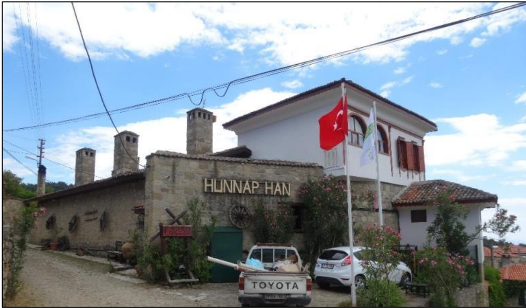
Şekil 3. 25 Konağın girişinin yapıldığı sokaktan görünümü [E. Alyakut, 2017]
