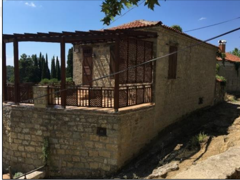
Şekil 3. 83 Yapıda kullanıcı müdahalesiyle oluşan değişimler [E. Alyakut, 2017]
