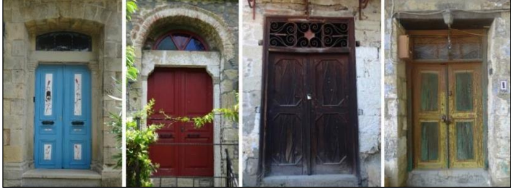
Şekil 3. 53 Çalışma alanındaki tepe pencereli kapılar [E. Alyakut, 2017]
