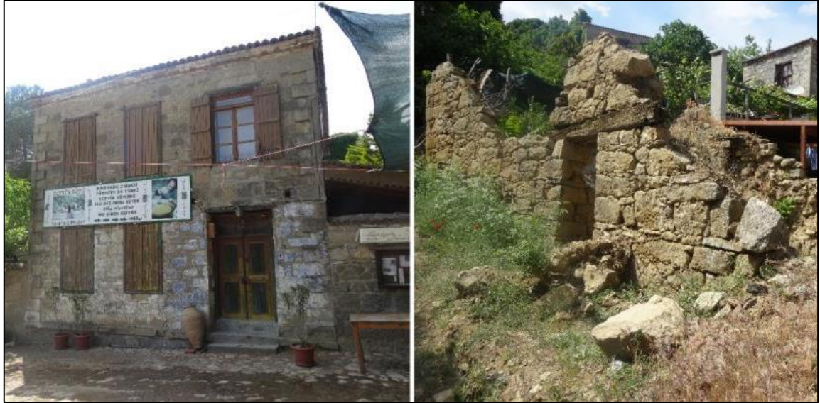
Şekil 3. 72 Aşağı Mahalle Meydanı'nda 551 Ada 5 Parselde yer alan yapı, Günümüzde harap durumda olan tescilli yapılardan biri, 551 Ada 4 Parsel [E. Alyakut, 2017]
