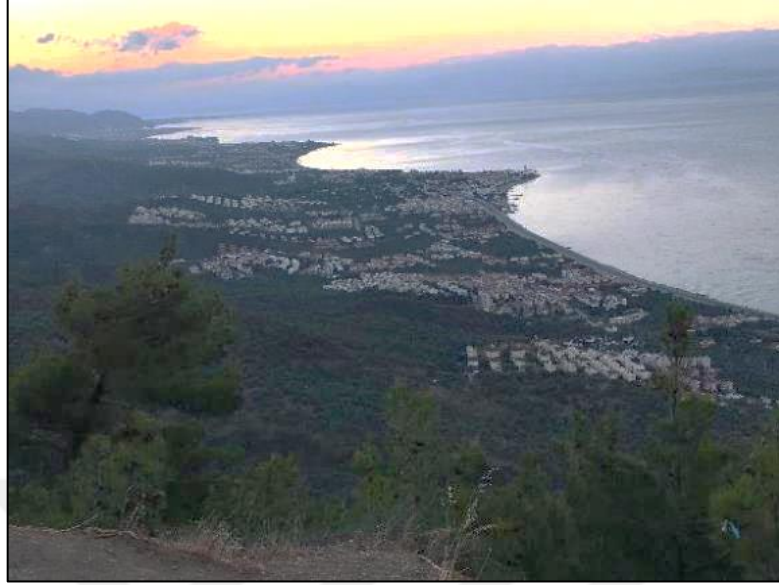
Şekil 3. 82 Küçükkuyu beldesinde yeni inşa edilen yapılar [E. Alyakut, 2017]
