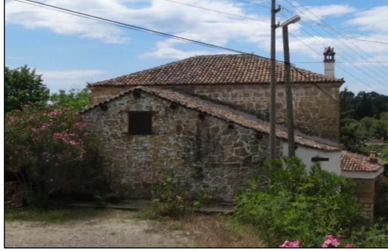
Şekil 3. 62 554 Ada 1 Parselde yer alan ek yapı [E. Alyakut, 2017]
