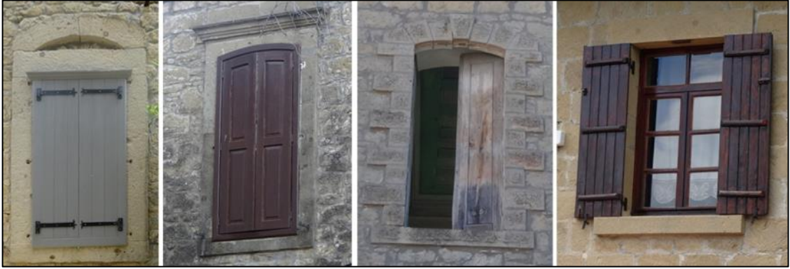
Şekil 3. 56 Çalışma alanında yer alan söveli pencereler [E. Alyakut, 2017]
