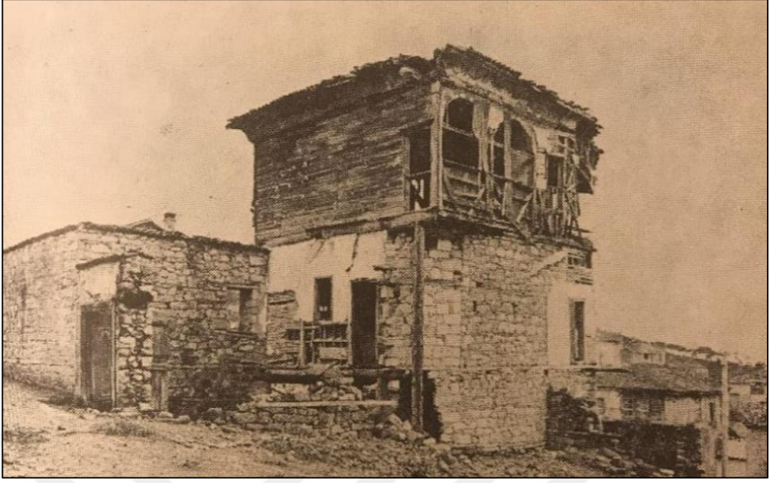
Şekil 3. 24 İDMMA tarafından restorasyon projesinin hazırlandığı 1977 yılında konağın girişinin bulunduğu sokaktan görünümü [82]
