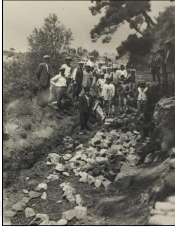
Şekil 3. 3 Küçükkuşu tarafından Adatepe girişindeki yolun yapımı [M. Gönenç]
