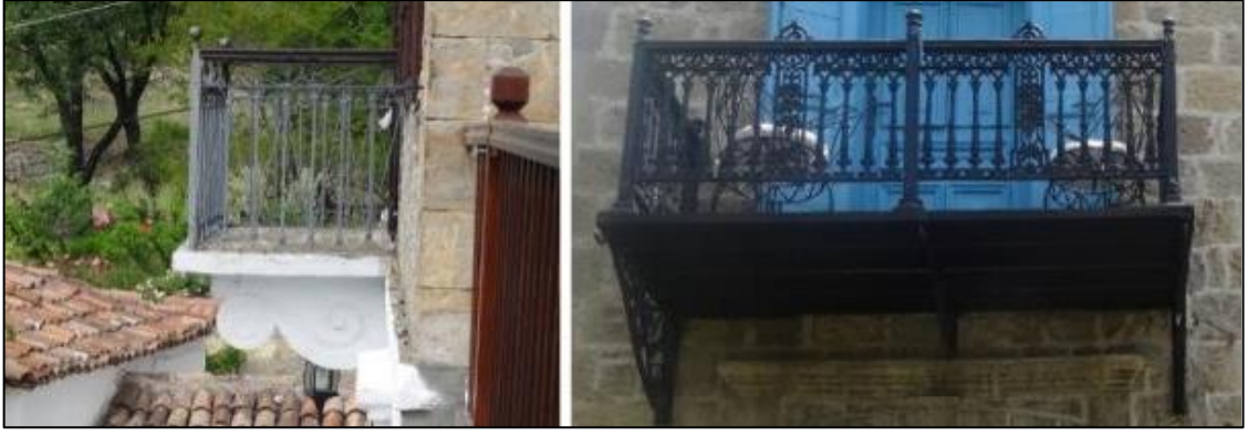
Şekil 3. 60 Çalışma alanındaki yapılarda yer alan balkonlar [E. Alyakut, 2017]
