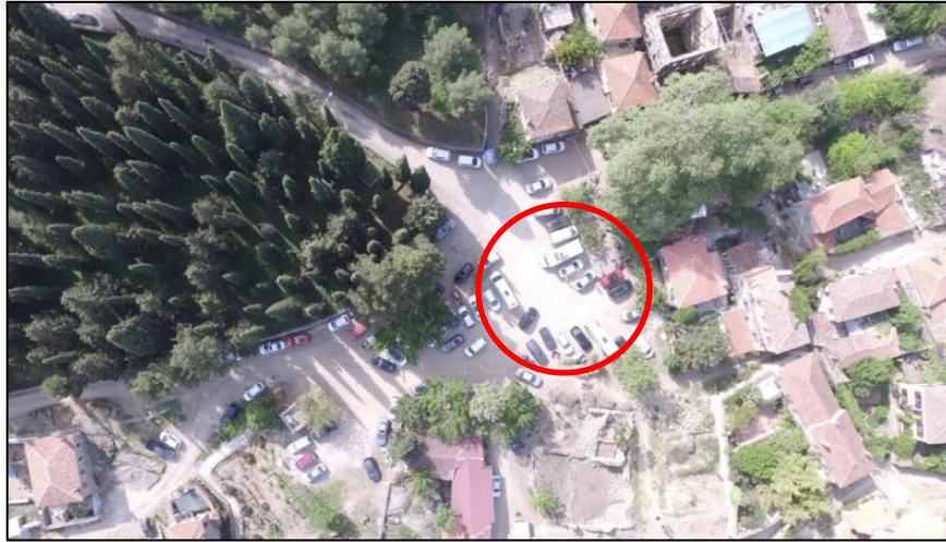
Şekil 5. 3 Aşağı Mahalle Meydanı eski kilise alanı [E. Alyakut, 2017]
