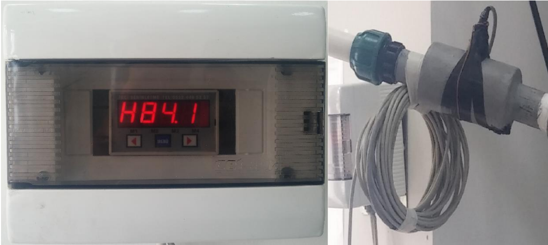
Şekil 3.11. Solda nem kontrol cihazı, sağda nem sensörü bağlantısı
