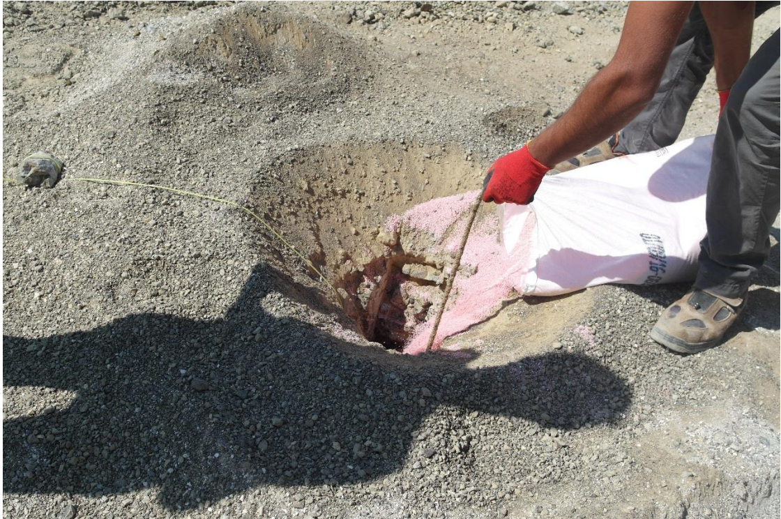
Şekil 5.5. Patlatma deliklerinde yapılan sıkılama işlemi.
