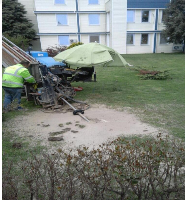
Şekil 3.8 Yönlendirilmiş Yatay Delgi ile Atıksu İmalatı
