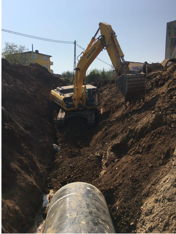
Şekil 3.6 Şevli Kazı Çalışması Örneği
