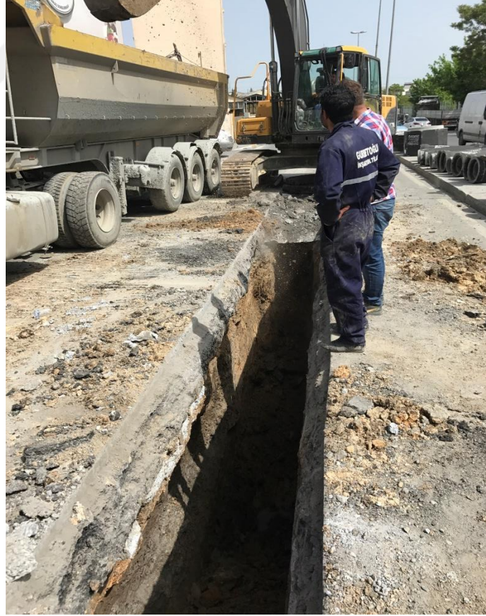
Şekil 3.1 Atıksu Açık Kazı İmalatı
