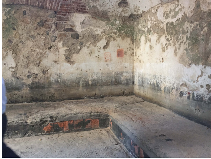
Şekil 4. 89 Traianoupolis termal banyolarının içinden görünüm (Kasım 2016)
