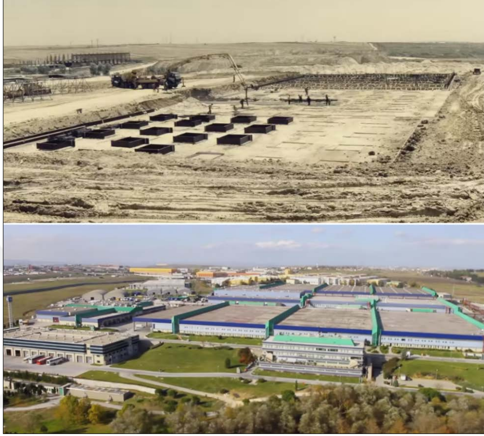
Foto 39: Mercedes-Benz'in 1995'te Esenyurt'ta kurduđu otobüs fabrikasının inşaatı (üstte), hala üretim yapılan fabrikanın bugünkü durumu (altta).
