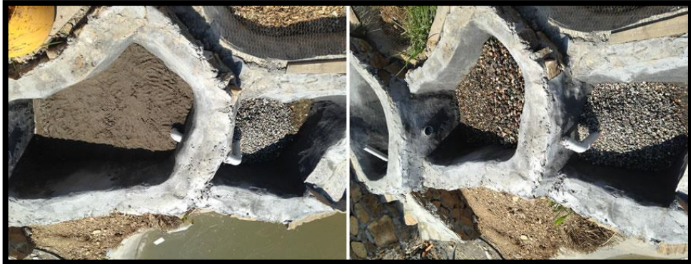
Şekil 4.12: Gri suyun temizlendiği filtrelene/havalandırma/temizleme havuzlarından fotoğraflar (Kaynak: Anonim, 2018n).
