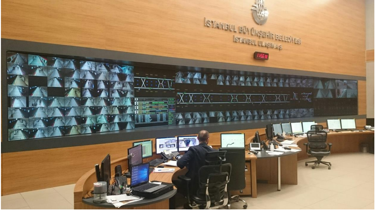
Şekil 2.9 Kadıköy-Kaynarca metro hattı kumanda merkezi genel bir görünüm
