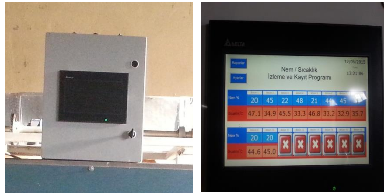
Şekil 3.9. Sıcaklık / nem kayıt cihazı
