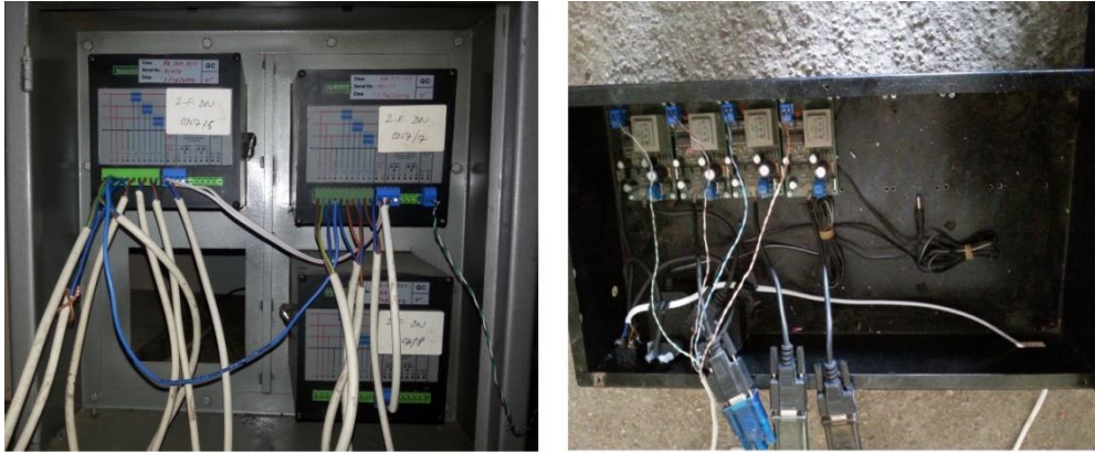
Şekil 3.36. Enerji analizörü bağlantıları
