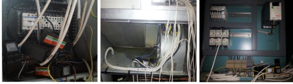
Şekil 3.35. Sistemlerin akım trafosu bağlantısı
