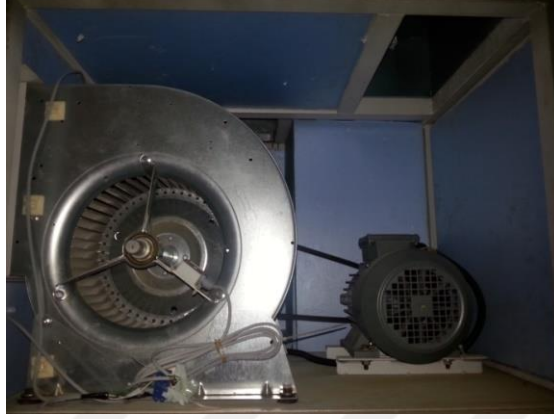
Şekil 3.42. Kurutma sistemi fan motoru devir sayısının ölçümü
