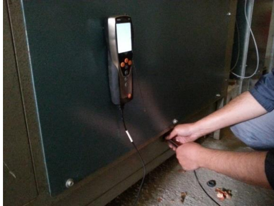
Şekil 3.45. Kurutma kabini hava hızı ölçümleri
