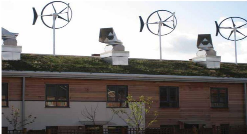
Şekil 4. 8 Hem enerji üretiminin hem de geniş tip yeşil çatı sistemlerinin örneği [75]
