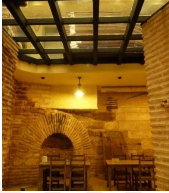
Şekil 125. Peykhane Sokak'taki altyapı
