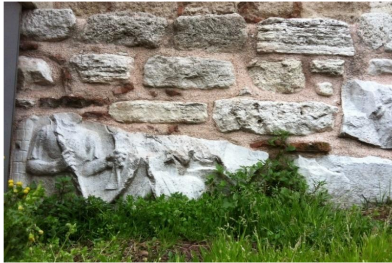
Şekil 128. Beyazıt Hamamı Müzesi dış duvarı
