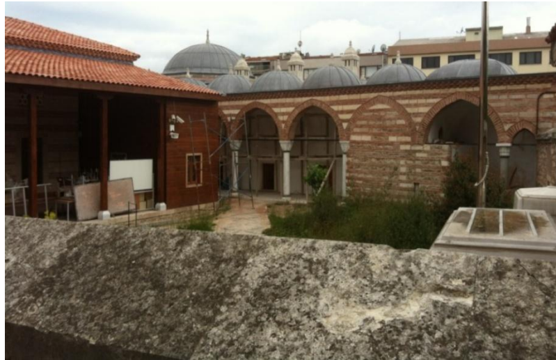
Şekil 135. İsa Kapısı Medresesi
