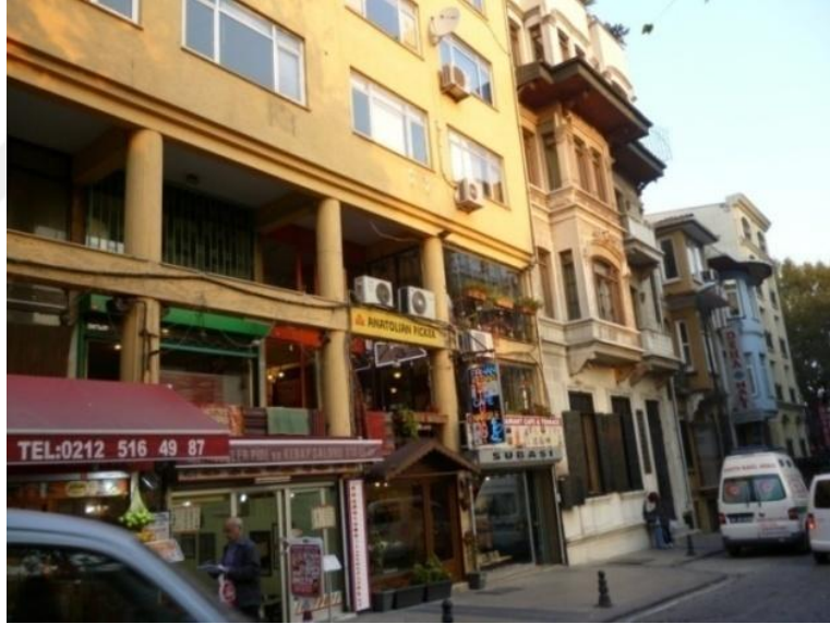
Şekil 124. Peykhane Sokak altyapılar üzerindeki binalar
