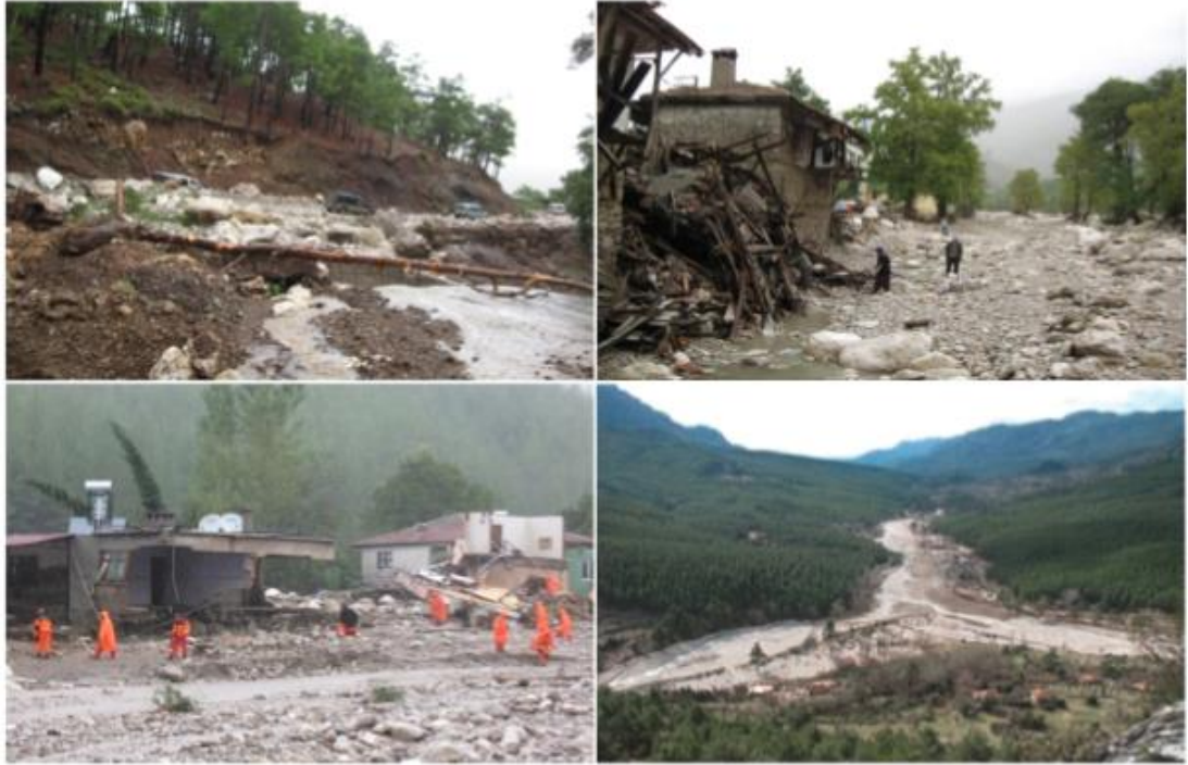
Şekil 5.4. Haskızılören köyü sel sonrası görünüm (Deniz, 2012)
