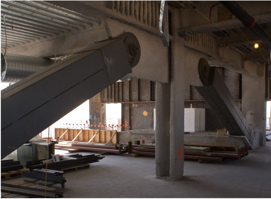
Şekil 2.2 : Burkulması önlenmiş çelik çapraz uygulaması.
