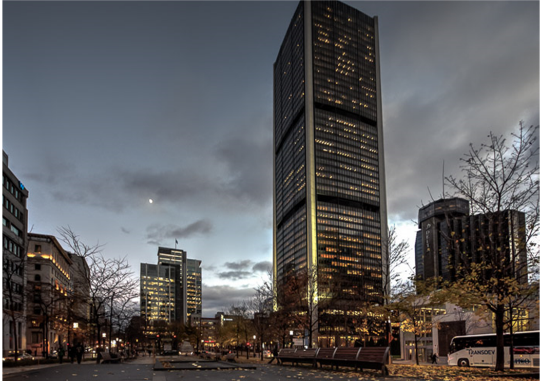
Şekil 1.3 : Dıştan destekli yüksek bina, Place Victoria.
