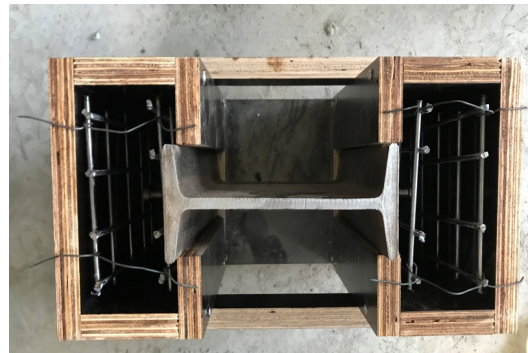
Şekil 3.17 : Beton donatılarının kalıpta yerleştirilmesi.
