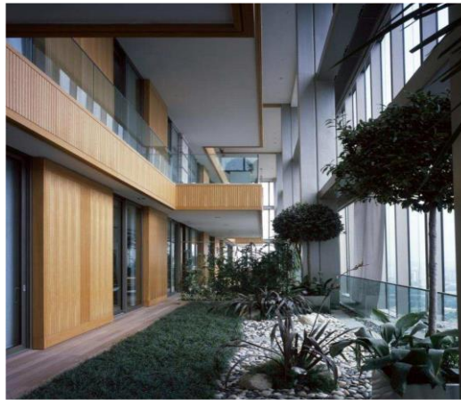
Şekil 2.1. Sapphire İstanbul, kış bahçesi görünümlü cephe boşluğu (Tabanlıoğlu, 2016)
