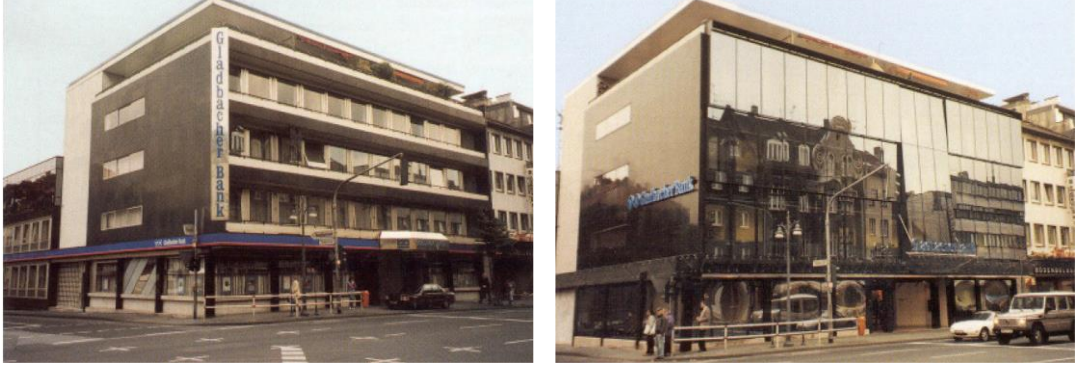
Şekil 2.53. Gladbacher Bank binası yenilenme öncesindeki (solda) ve sonrasındaki (sağda) durumu (Schrammen, 2015)
