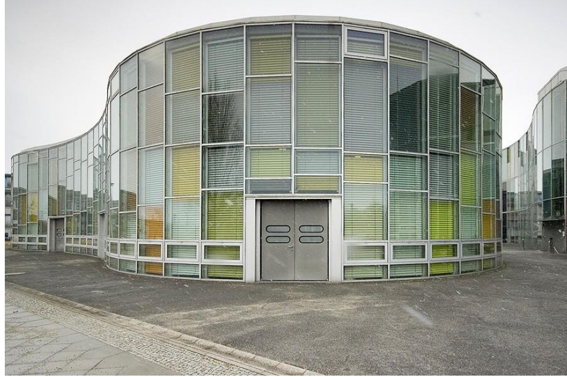
Şekil 2.30. Fotonik Merkezi Binası, Şaft Tipli Çift Kabuk Cephe Sistemi (Mimoa, 2016)
