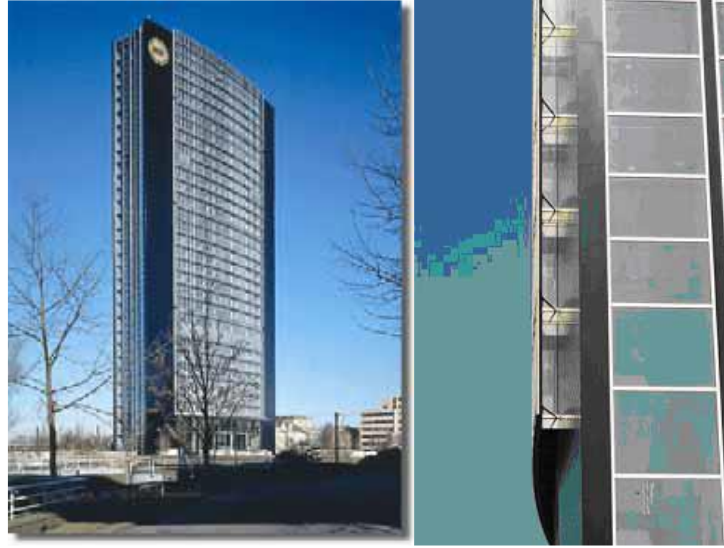
Şekil 2.50. ARAG 2000 Tower Görünüşleri (Structurae, 2016)
