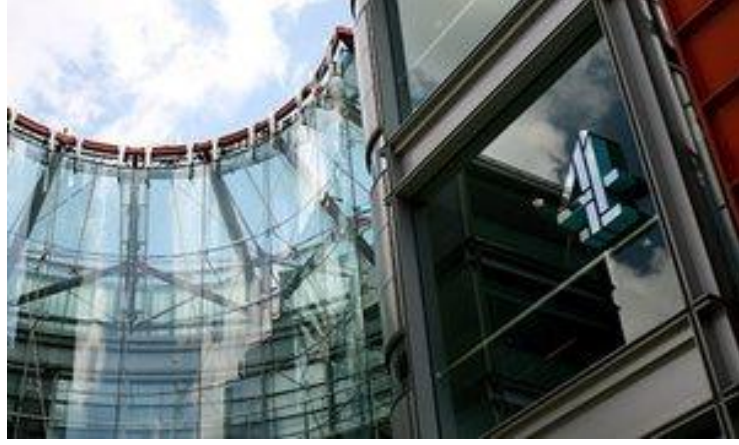
Şekil 2.13. Channel 4 Binası, Londra - Asma Strüktür Sistemi (Theguardian, 2016)
