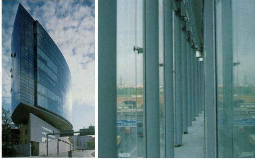
Şekil 2.33. Halenseestrasse Binası ve Cephe Boşluğunun görünüşü (Ünal, 2006)
