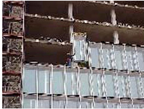
Şekil 2.37. Kutu pencere tipi çift kabuklu cephe montajı (Poirazis, 2004)
