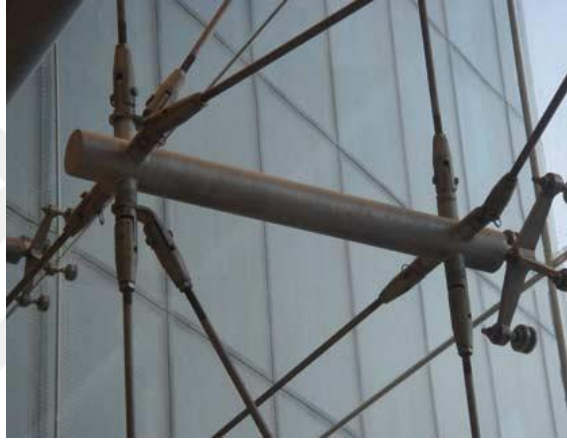
Şekil 2.12. Hybrid Destekli Sistem Bağlantı Örneği (Raf, 2017)
