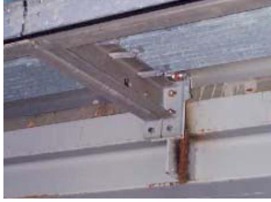
Şekil 2.9. Döşeme alnından bağlantı detayı (Uuttu, 2001)
