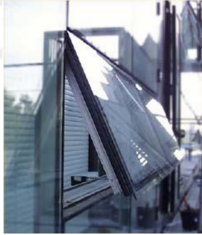
Şekil 2.29 Doğal havalandırmalı cephelerde kullanılan mekanik pencere örneği (Loncour vd., 2004)
