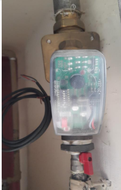
Şekil 6.4. 0-10 V sinyal aralığında çalışan oransal vana.
