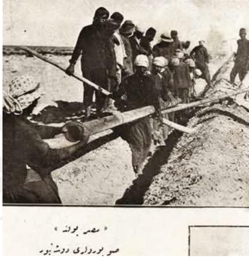
Mısır yoluna su boruları döşeniyor
