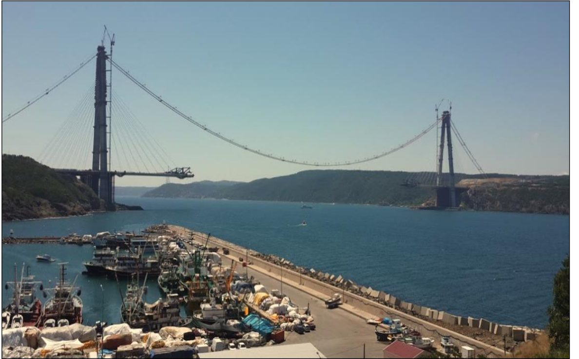
Foto 29: Poyrazköy'den 3. Köprü'nün Genel Görünümü (Temmuz, 2015)
