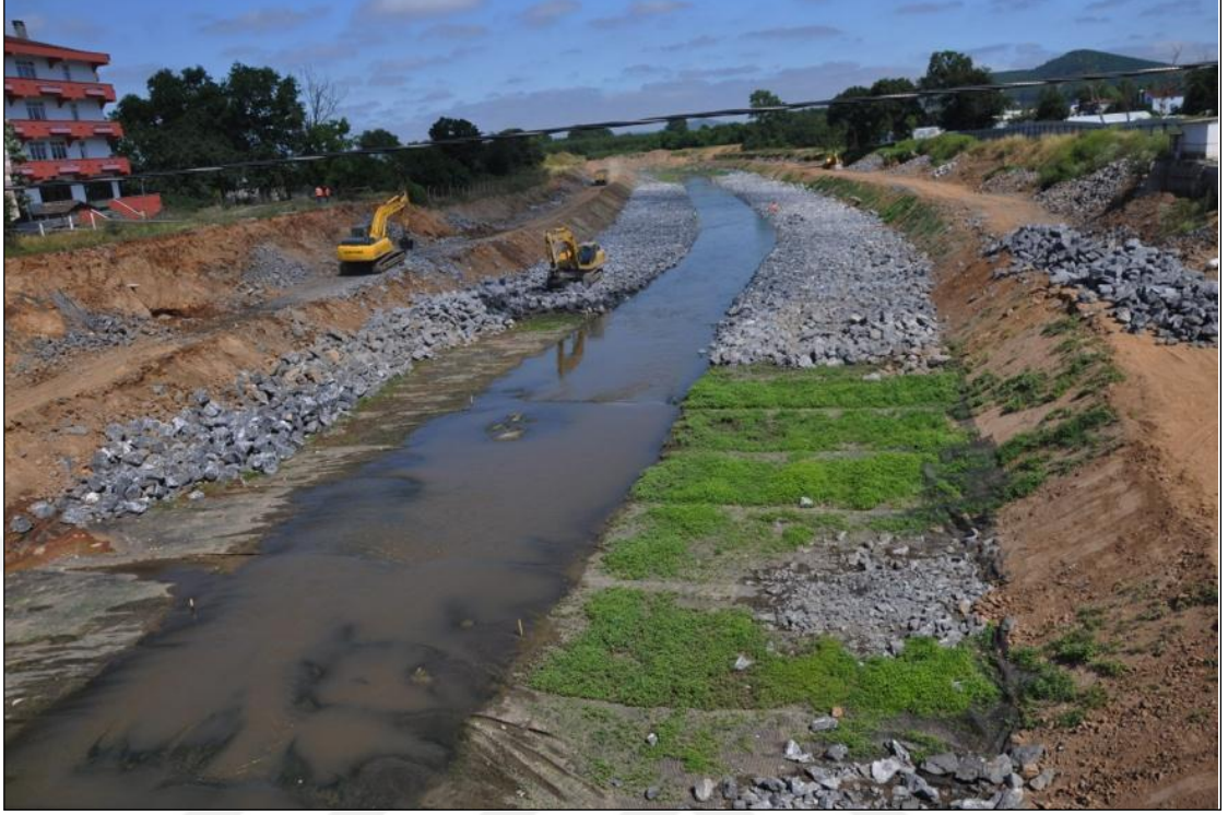
Foto 17: Riva Çayı Üzerinde Yapılan Yatak Düzenleme Çalışmaları
