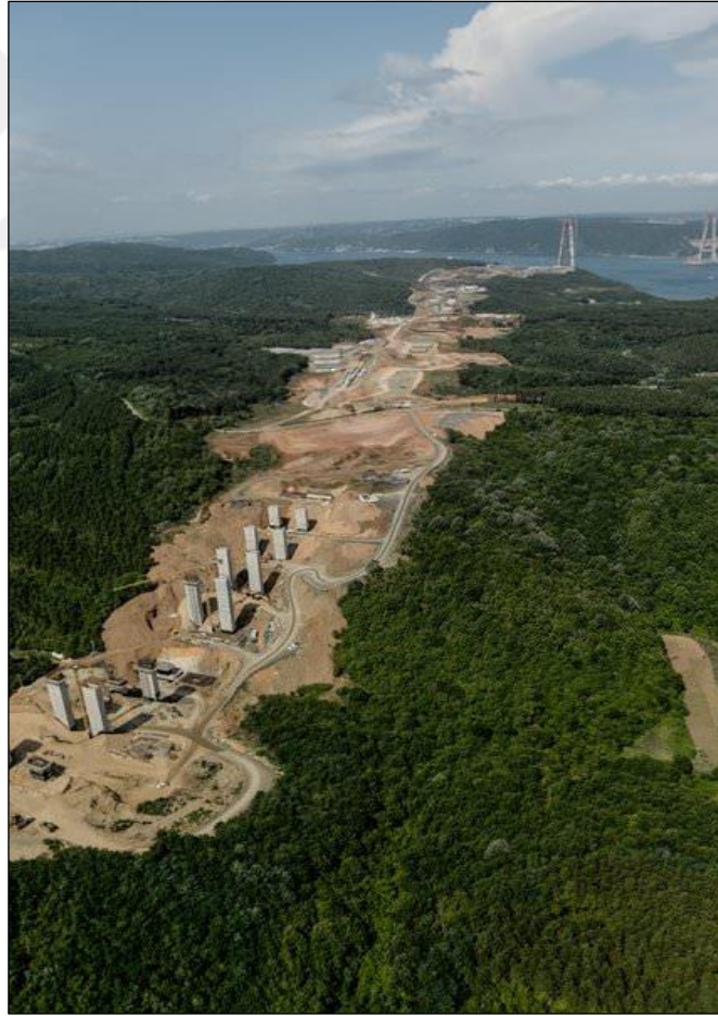
Foto 25: 3. Boğaz Köprüsü İnşaatından Görüntü
