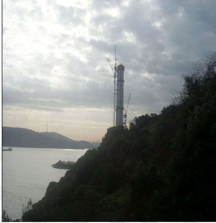
Foto 27: Köprü İnşaatı Devam Ederken, Poyrazköy Ayağının Garipçe'den Görünümleri (Ocak, 2014)
