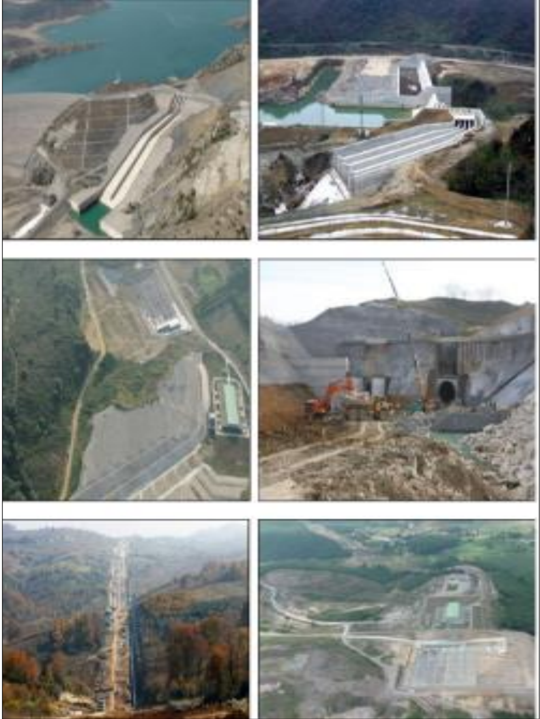
Foto 36: Melen Projesi Kapsamındaki Melen Barajının Görüntüleri
