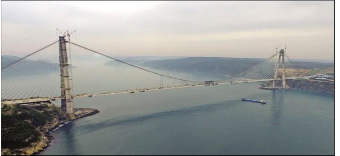
Foto 23: YSS Köprüsü Nisan 2016 Yılında Yapım Aşamasından Genel Görünümleri (tr.wikipedia.org)
