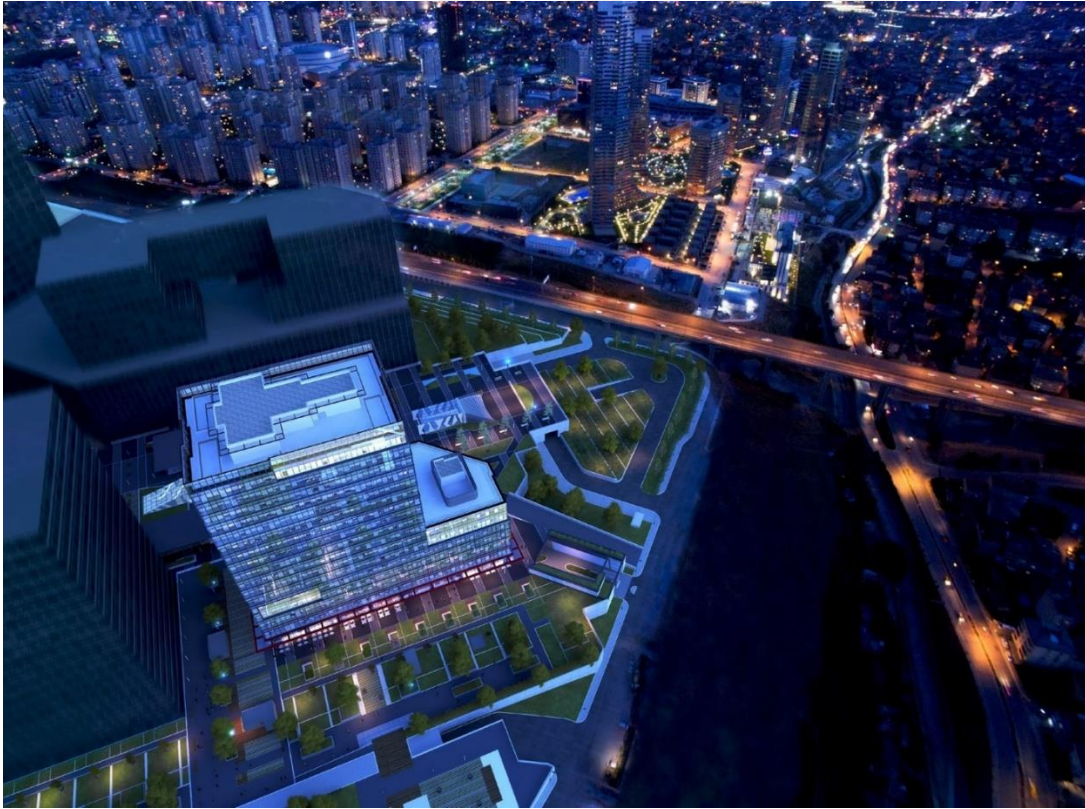
Şekil 5.15 : Projenin Dış Görünümü.
