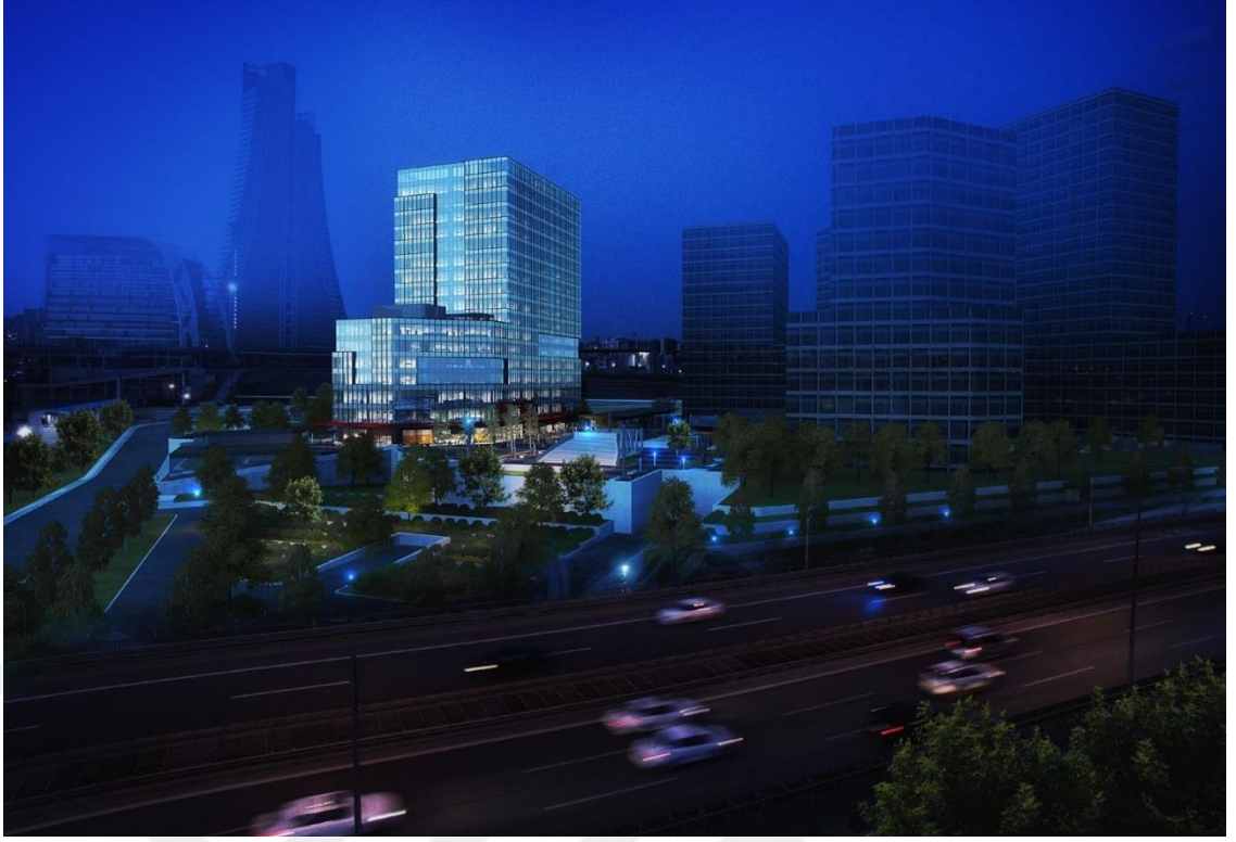
Şekil 5.16 : Projenin Dış Görünümü.
