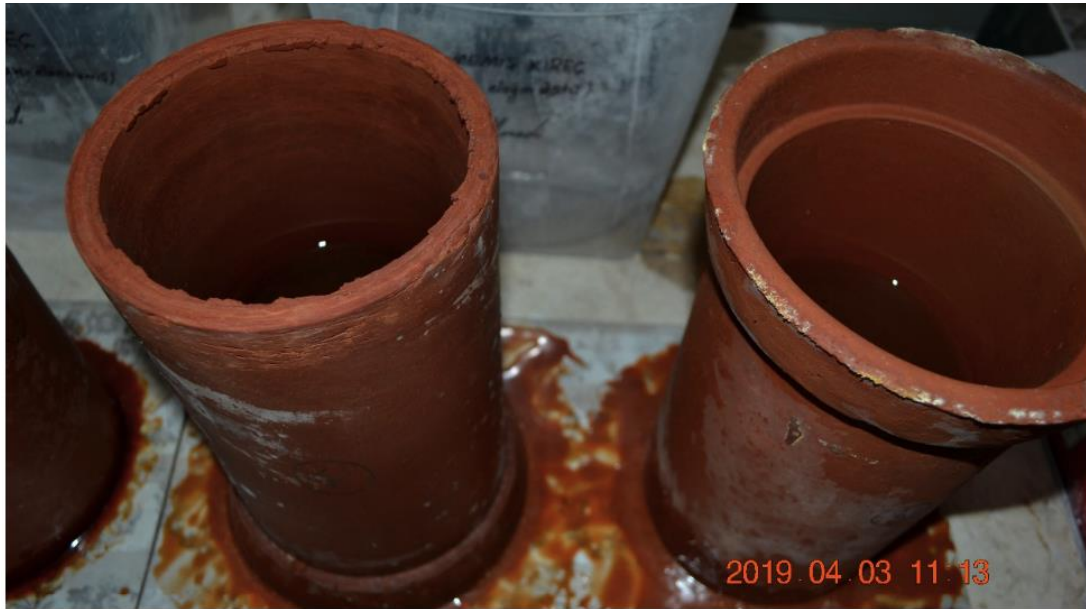
Şekil 4.33 : 3 hafta sonra su seviyesi ve künk cidarında çiçeklenme ve tuzlanma.
