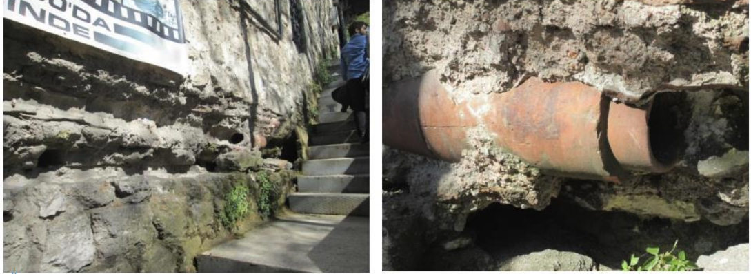
Şekil 2.2 : Süleymaniye külliyesi imaret duvarında suyolu ve künk.
