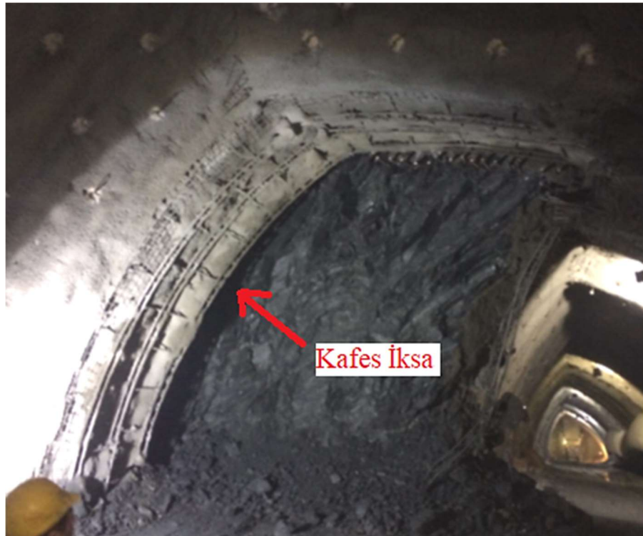
Şekil 4.10 : Kafes iksanın tünel içine yerleştirilmesi (Cebeci Tüneli).
