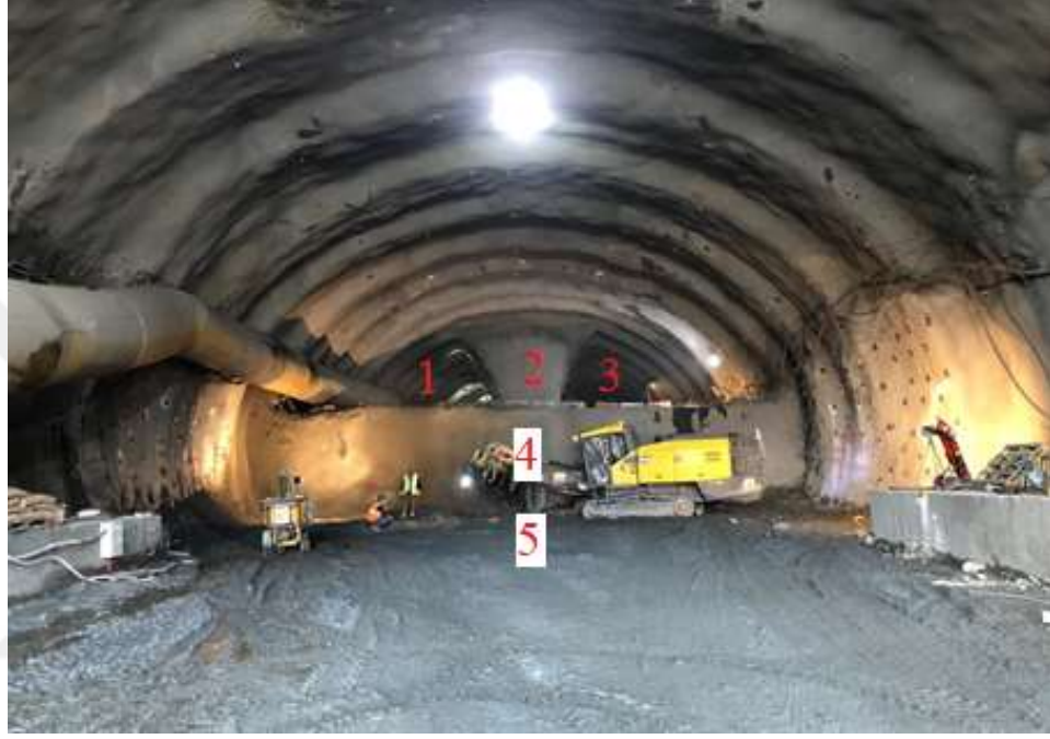
Şekil 4.3 : C3 sınıfında açılan tünelin aşamaları (Cebeci Tüneli).
