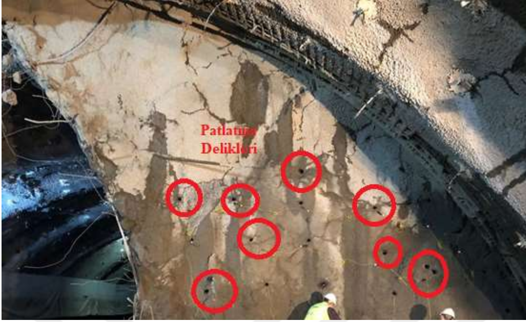
Şekil 2.8 : Açılan deliklere patlayıcı yerleştirilmesi (Cebeci Tüneli).
