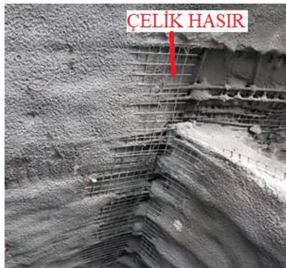
Şekil 4.9 : Tünel içindeki püskürtme beton kaplı çelik hasır (Cebeci Tüneli).
