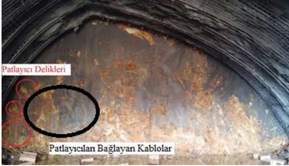
Şekil 4.5 : Patlama paternine uygun tünel aynası (Cebeci Tüneli).
