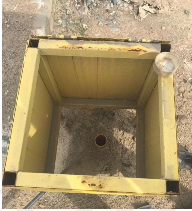
Şekil 5.2 : İnklinometre borusu ve zemine kurulumu (Cebeci).
