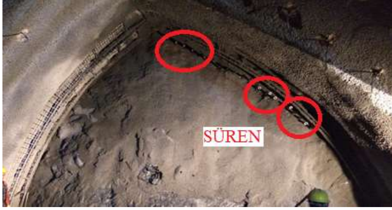
Şekil 4.12 : Tünel aynasına uygulanan sürenler (umbrella arch) (Cebeci Tüneli).
