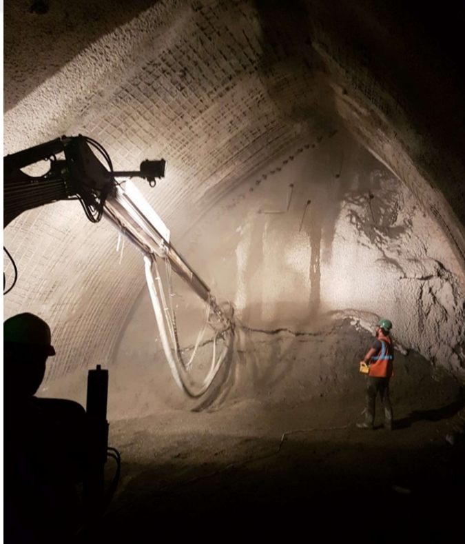
Şekil 4.7 : Püskürtme betonun uygulanması (Cebeci Tüneli).
