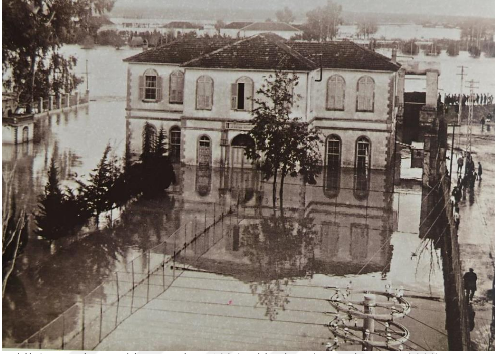
Şekil 4.5. Türkocağı binası, Adana 1936 sel baskını (Kaynak: ABB, 2009)
