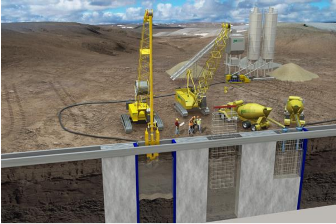
Şekil 7.6. Diyafram duvar uygulaması [72].
