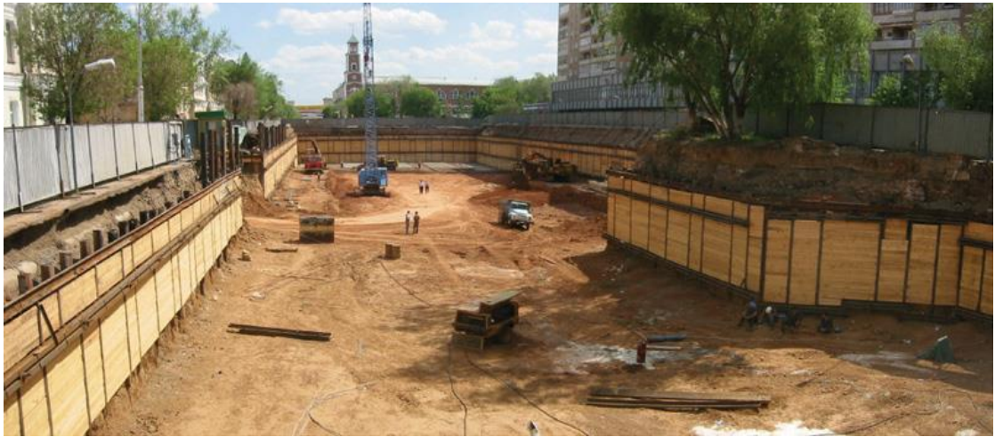
Şekil 3.12. Ahşap palplanş perde uygulaması [16].
