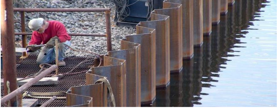
Şekil 3.14. Çelik palplanş perde uygulaması [22].
