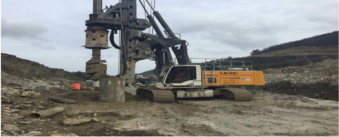
Şekil 3.16. Fore kazık makinesi [25].
