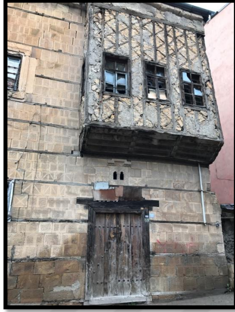
Foto 75: Üst katında ahşapların arası kerpiç dolgulu bir Bayburt Evi.
