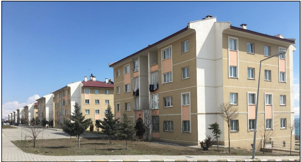
Şekil 3.38 : Deprem sonrası yapılan kalıcı konut yapıları.
