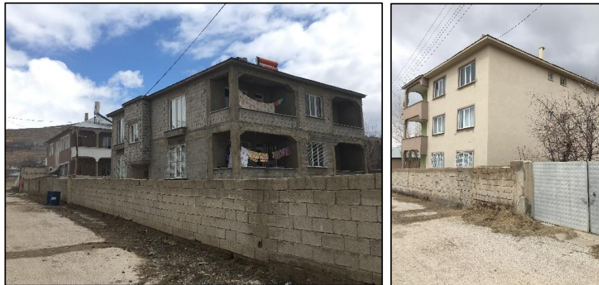
Şekil 3.19 : Mevcut yerleşmede 2 ve 3 katlı konut yapıları.
