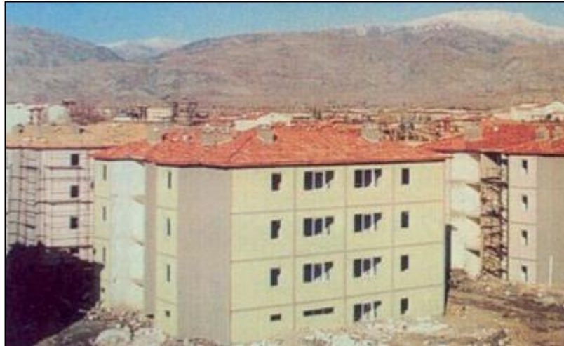
Şekil 2.20 : 1992 Erzincan deprem konutlar ve güçlendirme (Url-19).
