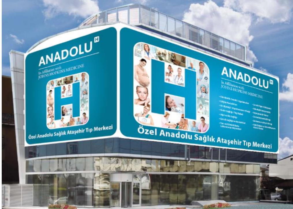
Şekil 103. Anadolu Sağlık Merkezi Ataşehir Tıp Merkezi Bina Cephesi
