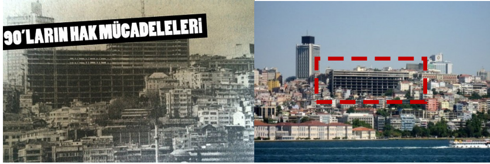
Şekil 4.26 : 1993 yılında 17 katı yıkılan Park Otel, (Yılmaz, 2014).
