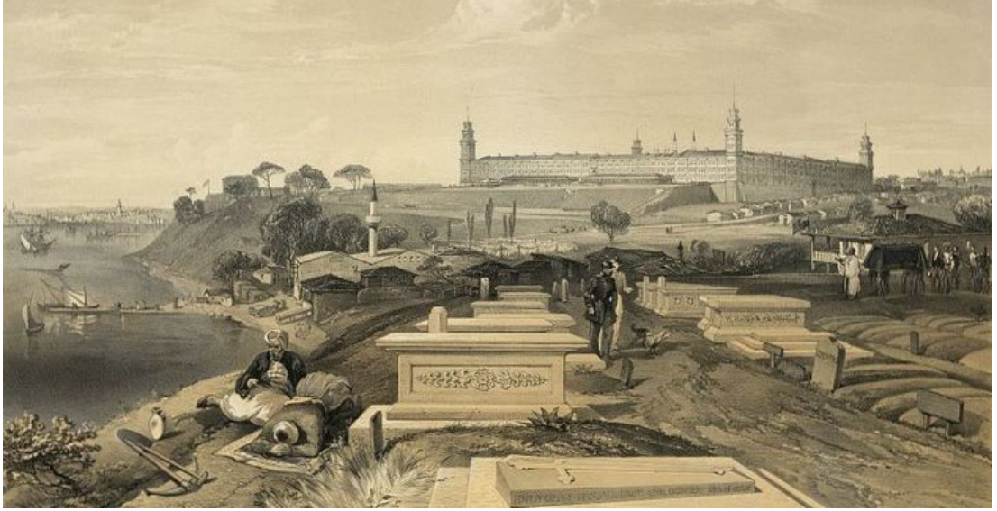
Şekil 4.16 : Selimiye Kışlası 19. yüzyıl, (Kaya Ö. , 2013).
