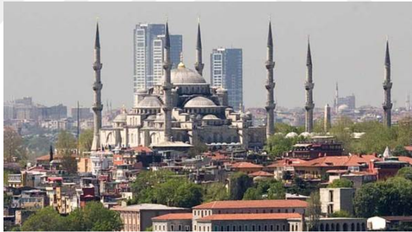
Şekil 4.30 : Sultanahmet Camii ve OnaltıDokuz gökdelenleri, (URL-26).
