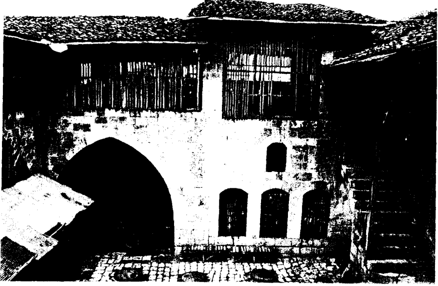
F 119. Avlunun kuzeydoğu cephesi
