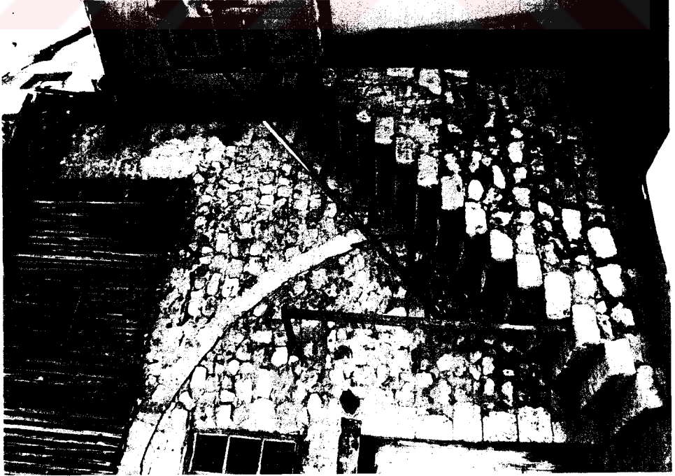
F 252. Müftüoğlu Sabunhanesi üst kata çıkan merdiven
