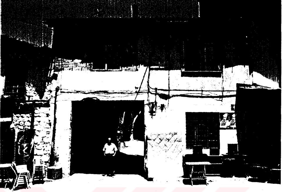
F 247. Müftüoğlu Sabunhanesi giriş cephesi
