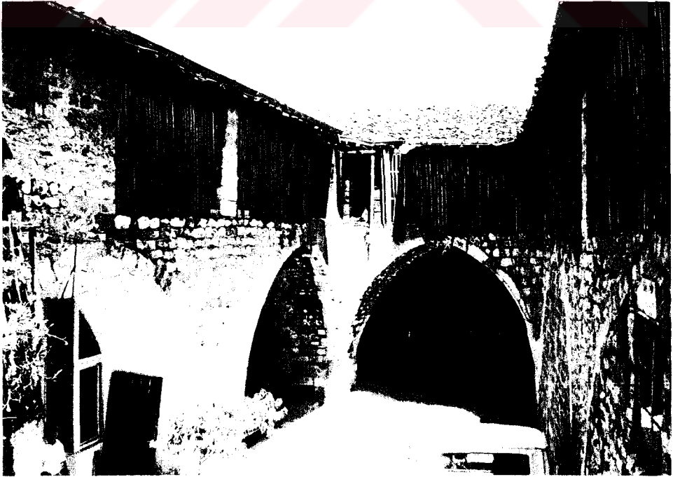
F 250. Müftüoğlu Sabunhanesi avlu
