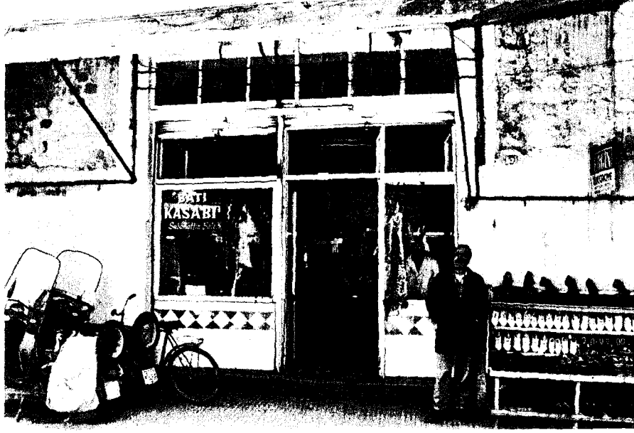
F 85. Hanın kuzeybatı cephesindeki üçüncü dükkan
