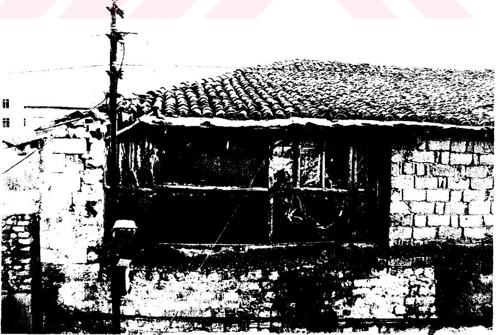
F 188. Üst kat kuzeybatı cephesi
