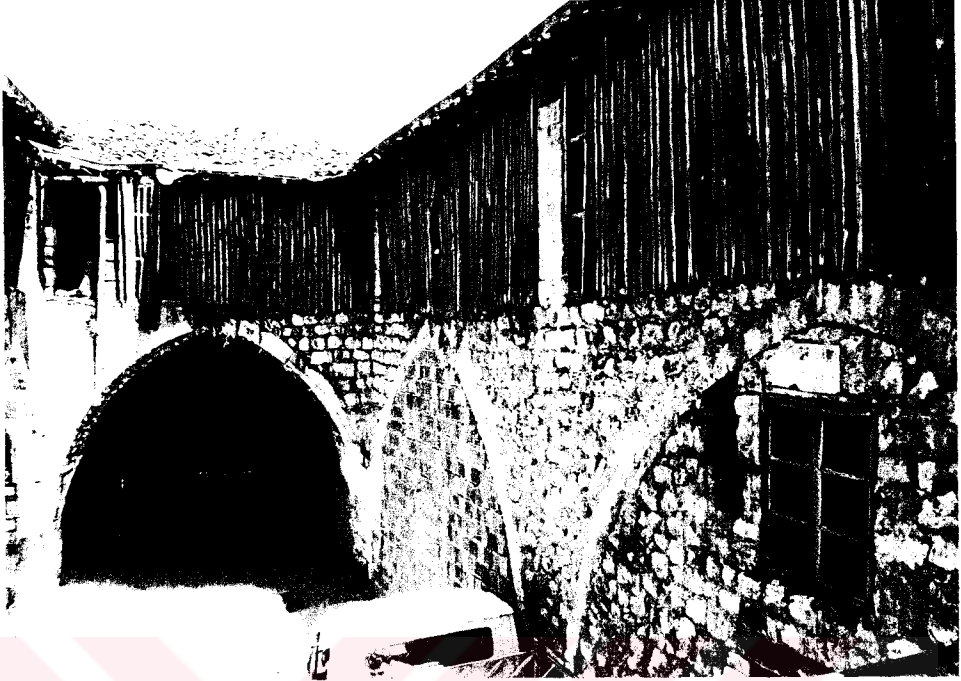
F 249. Müftüoğlu Sabunhanesi avlu
