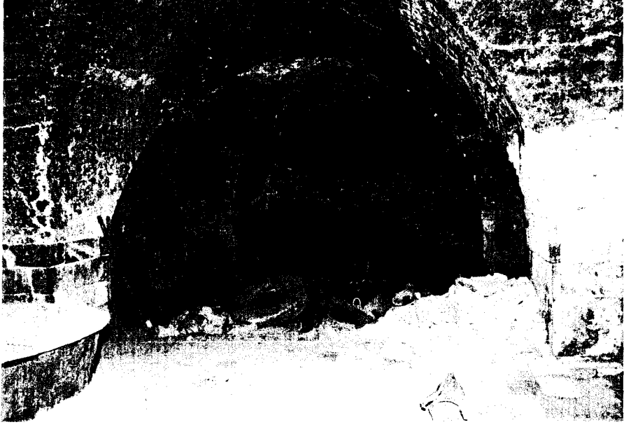
F 115. Kazanın güneybatısındaki tonozlu bölüm
