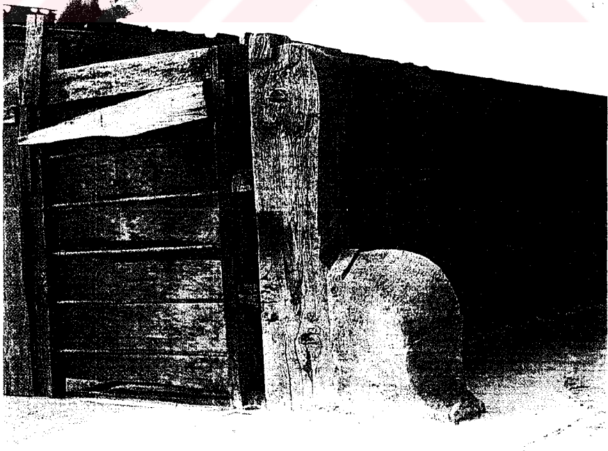
F 26. Taş konsol üzerine oturmuş çıkma (1973)
