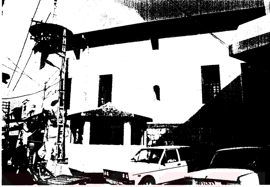
F 69. Restorasyon sonrası güney cephesi
