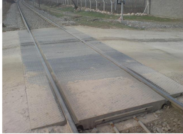
Şekil 2.19 : Kauçuk kaplamalı hemzemin geçit örneği [24].
