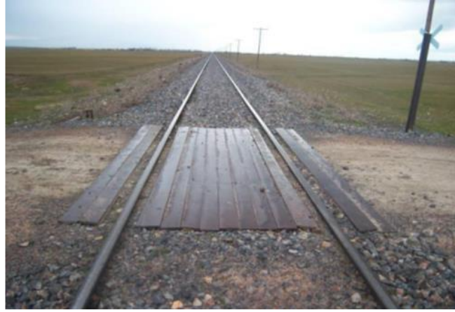
Şekil 2.17 : Çelik (ray) kaplamalı hemzemin geçit örneği [5].
