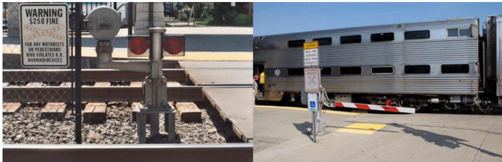
Şekil 2.55 : ABD’de hemzemin geçitlere yayalar için tesis edilmiş olan aktif uyarı ekipmanı örnekleri [63].
