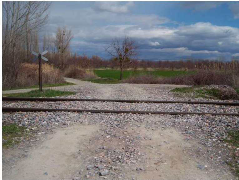
Şekil 2.13 : Balast–mıcır kaplamalı hemzemin geçit örneği [24].
