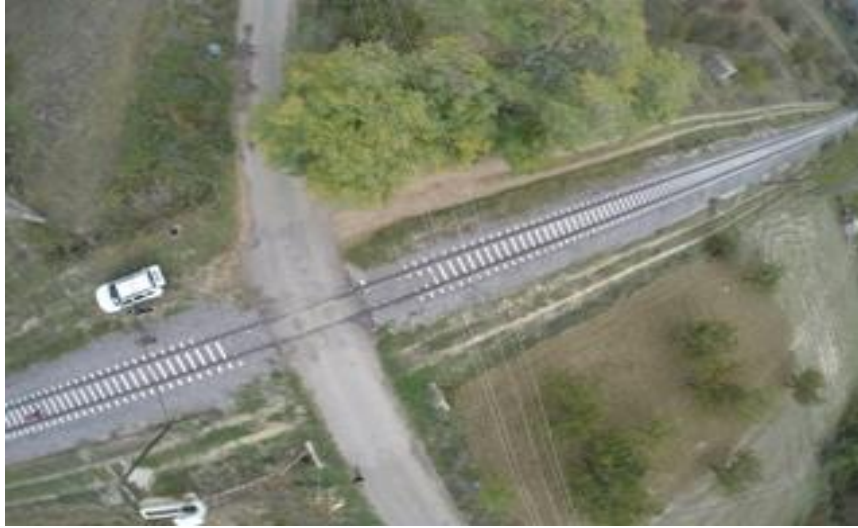
Şekil 2.7 : Hemzemin geçit örneği (kuş bakışı) [Kaynak: TCDD].
