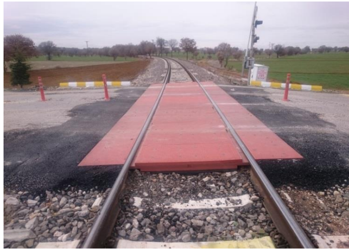
Şekil 2.21 : Kompozit kaplamalı hemzemin geçit örneği [Kaynak: TCDD].
