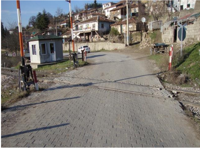
Şekil 2.16 : Kesme/parke taş kaplamalı hemzemin geçit örneği [24].
