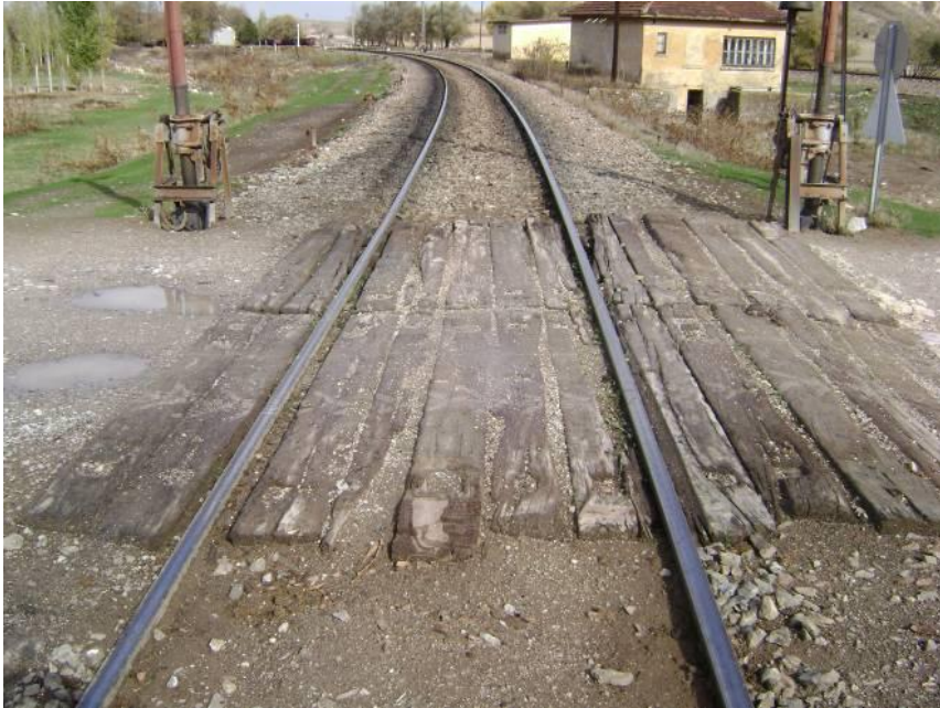
Şekil 2.14 : Ahşap travers kaplamalı hemzemin geçit örneği [24].
