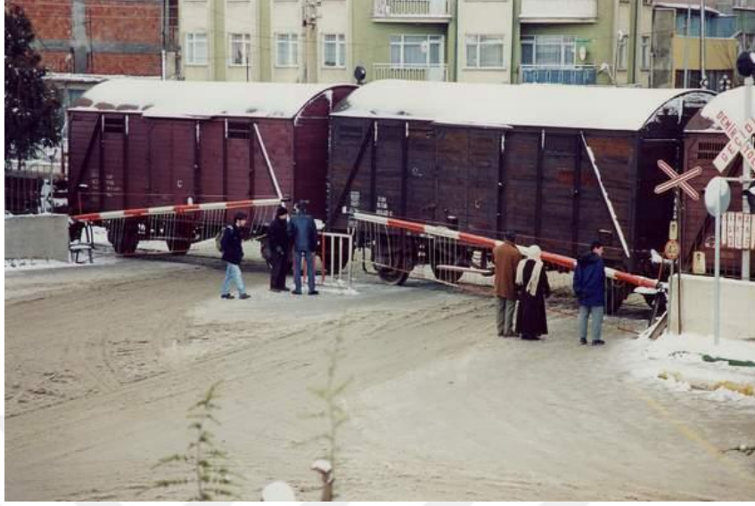
Şekil 2.11 : Bekçili–bariyerli hemzemin geçit örneği [9].
