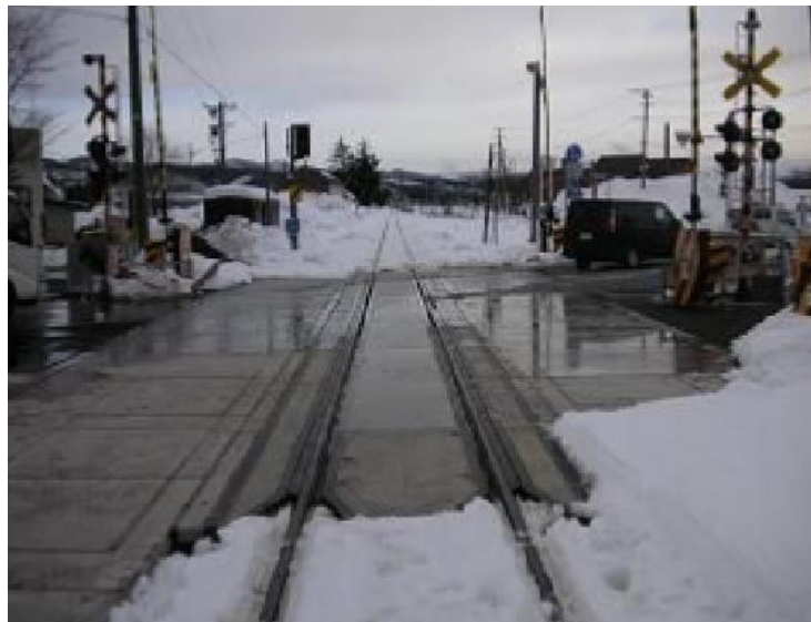
Şekil 2.57 : Japonya’dan buzlanma önleme düzeneği kurulmuş bir hemzemin geçit örneği [61].
