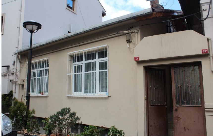
İmam Evi Güney Batı Cephesi
