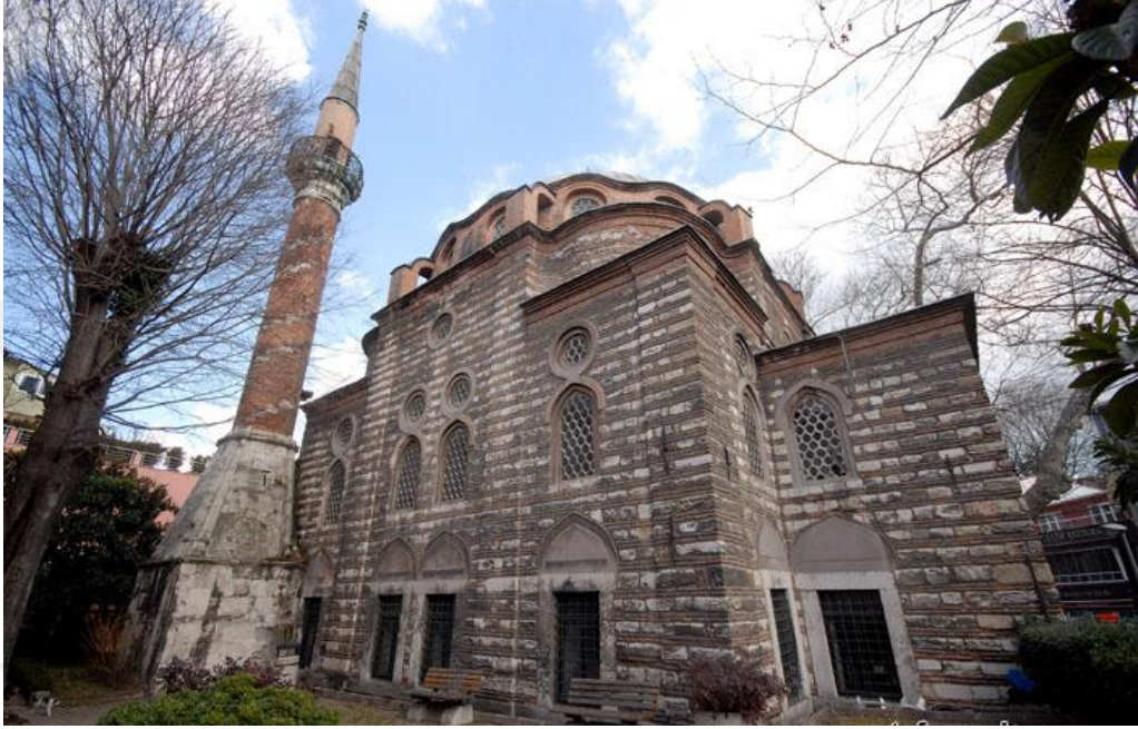
Batı Cephesinden Zeyneb Sultan Camii Pencerelerinin Görünüşü
