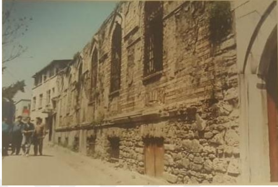
Fotoğraf 62: Medresenin Duvar Örgüsü
