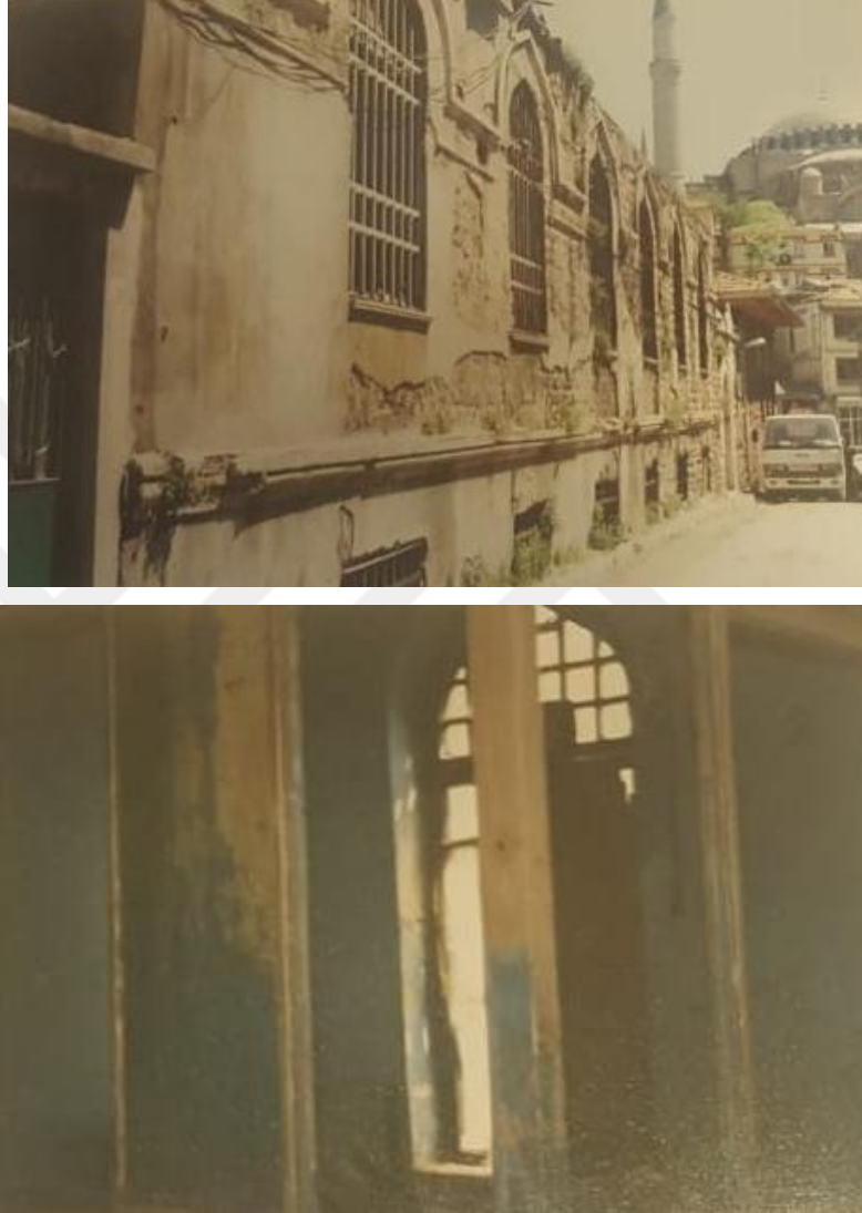
Fotoğraf 54: Medresenin 1997 Onarımı Öncesindeki Durumu
