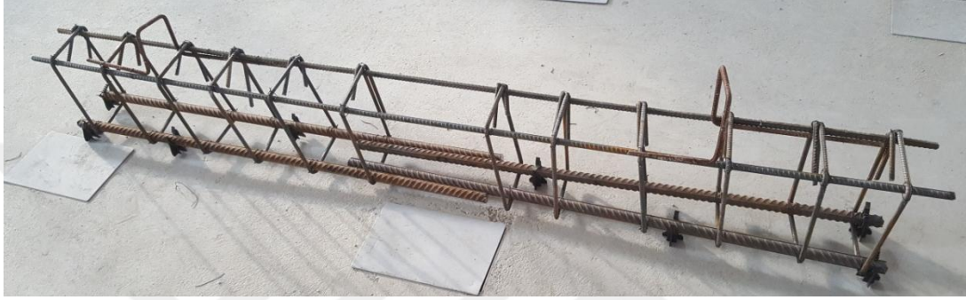
Şekil 3.16. Kiriş donatısının teşkili
