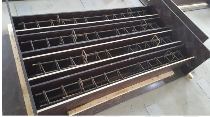
(a) Donatısı yerleştirilmiş kiriş kalıpları
