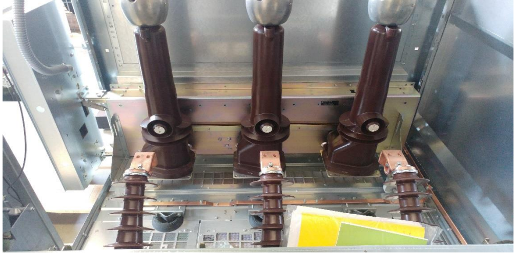
Şekil 3.6: Modüler hücre içinde SF6 gazlı kesicinin görünüşü.
