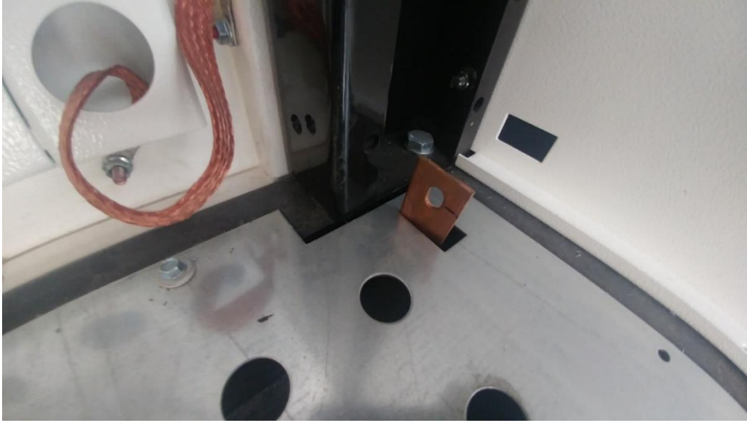
Şekil 4.16: Koruma topraklaması bağlantısı için kullanılan bakır çubuklar.
