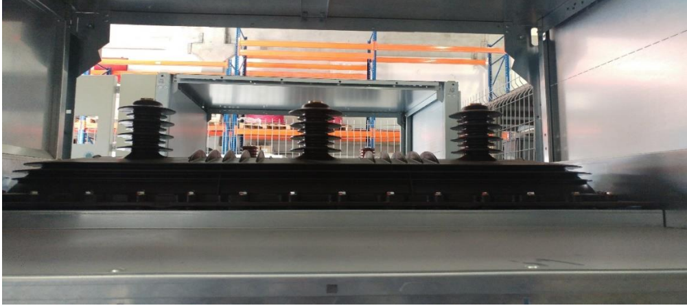
Şekil 3.5: Modüler hücre içinde ayırıcı görünüşü.
