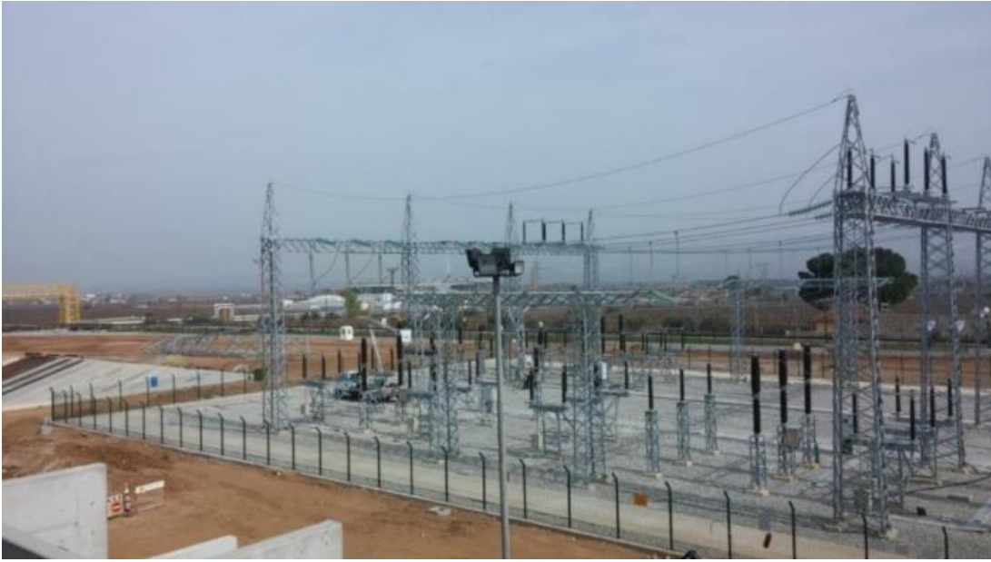
Şekil 3.1: Açık tip trafo merkezleri.
