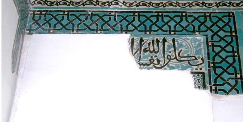
Resim 104: Doğu Duvarı 7 No’lu Alınlık Panosu
