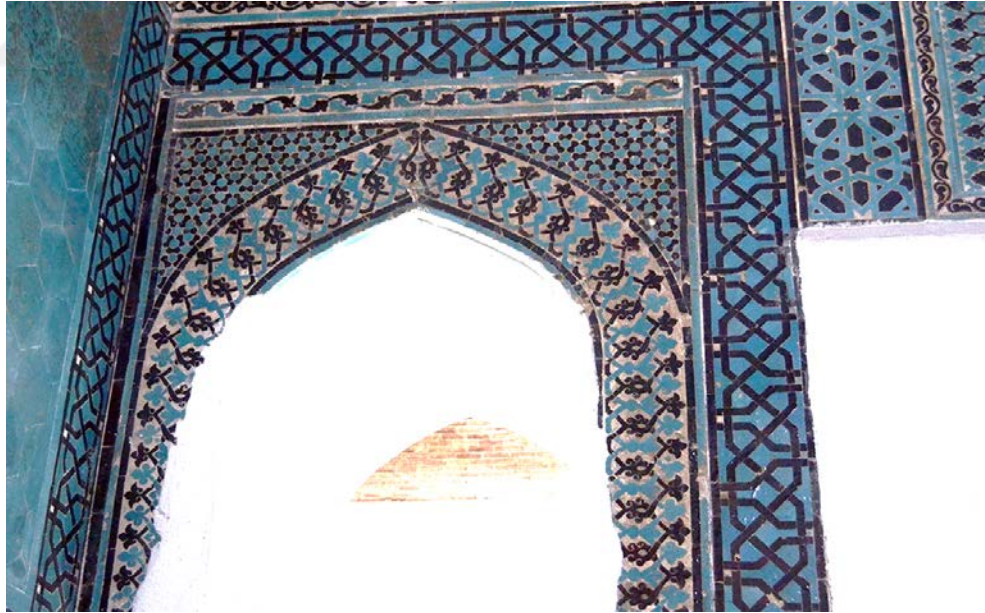
Resim 109: Batı Duvarı 12 No’lu “Türbe Girişı” Alınlık Panosu
