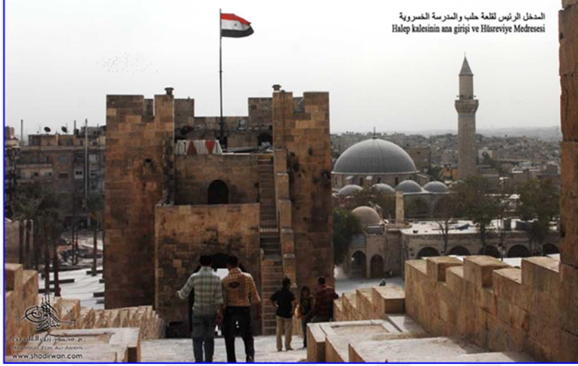
Şekil 2.17; Halep kalesinin önünden Osmanlı klasik Üslubunda inşa edilen Hüsreviyye binası
