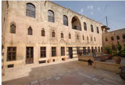
Şekil 3.61; Gazale evindeki iç cephe (M. Zeyn El Abidin, 2009).
