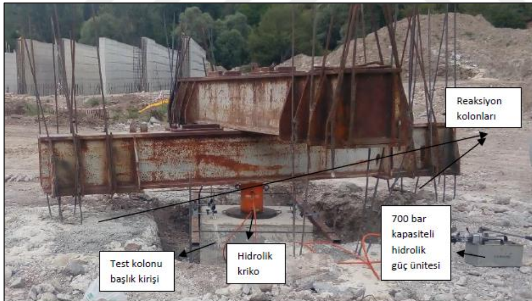
Şekil 6.8. Jet grout kolon yükleme deneyi düzeneği
