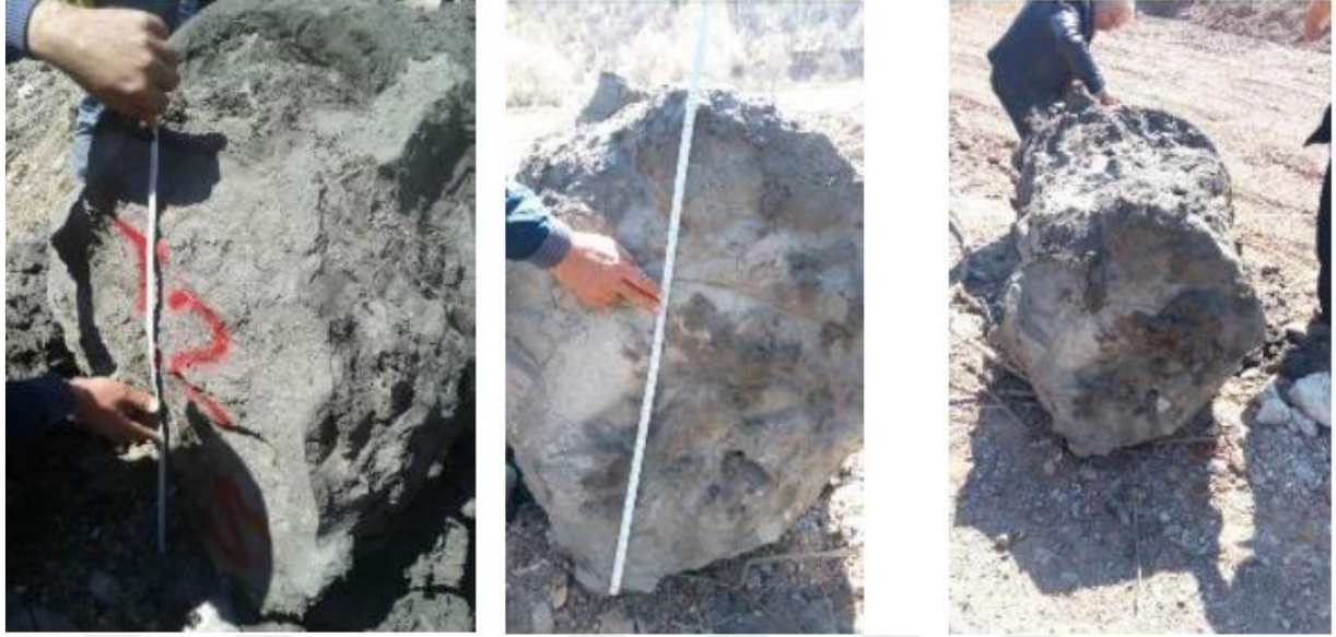
Resim 6.2. Arazide yapılan jet grout test kolonları çap kontrolü
