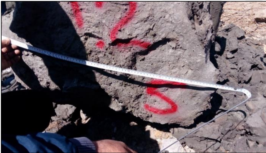
Resim 2.1. Jet grout kolonu rnek ap kontrol
