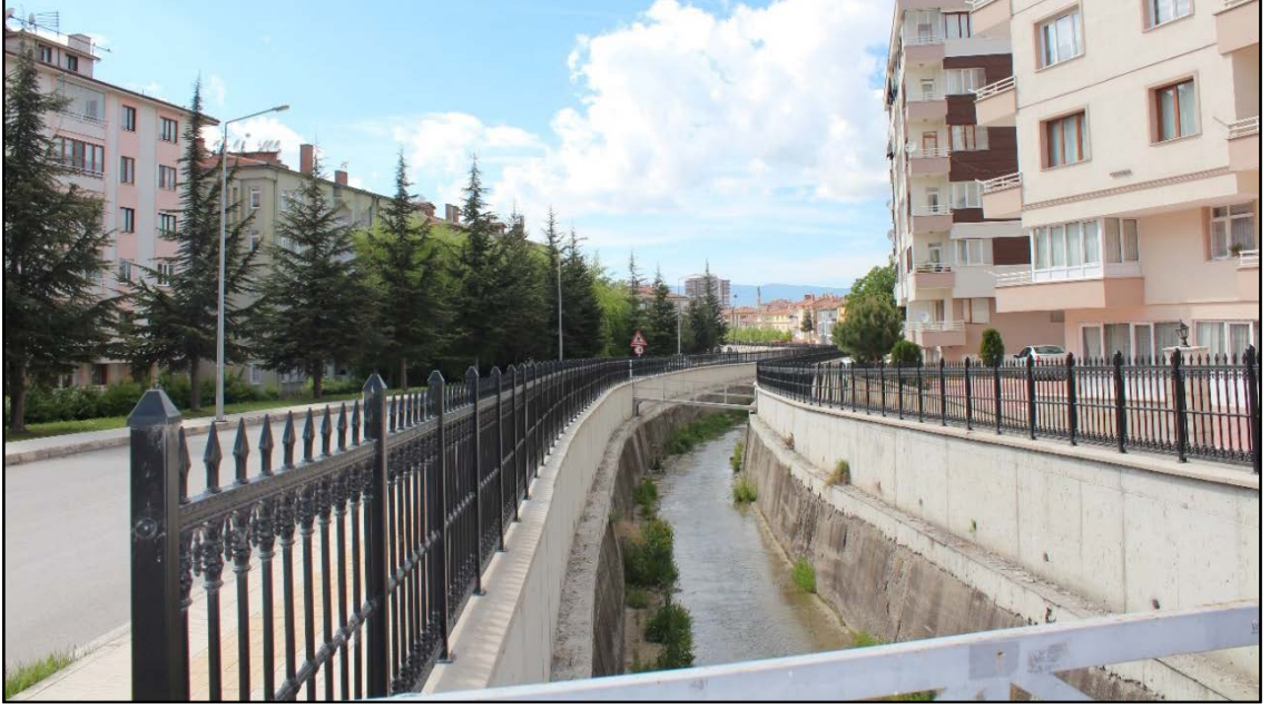
Fotoğraf 11: Melikgazi Deresi, Devlet Hastanesi Kavşağı-Nadik Senti Arası Duvarlı Kanal; kanal yapımıyla birlikte kentsel yayılım hızlanmıştır (2019).
