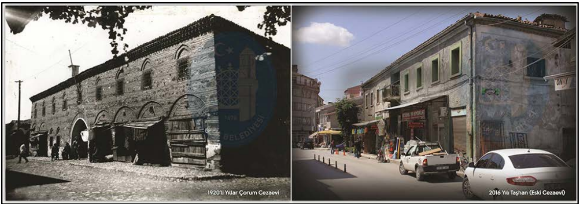
Fotoğraf 39: Çezaevi; İlk olarak çezaevi olarak kullanılan bu bina günümüzde iç çeper kuşak içerisinde çeper kuşak arazi kullanım özelliğini kaybetmiştir. Kaynak: URL 7.
