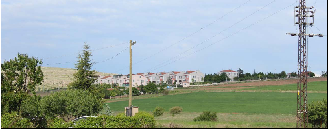
Fotoğraf 2: Slimkent konutları; Buharaevleri mahallesi sınırları içerisinde olmasına rağmen ikincil ev sahipliğinden dolayı kentsel konutların kırsal alanda kurulması ile oluşmuş bir yerleşim birimidir. Slimkent'in kurulmasından sonra yakınlarında Haskent isimli yeni bir yerleşim birimi kurulmuştur.
