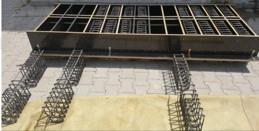
Şekil 2.10. Kiriş donatılarının kalıplara yerleştirilmesi
