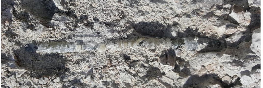
Şekil A.10. Nervürlü GFRP (GR) donatının betondan sıyrılması sonrası yüzeyindeki deformasyon
