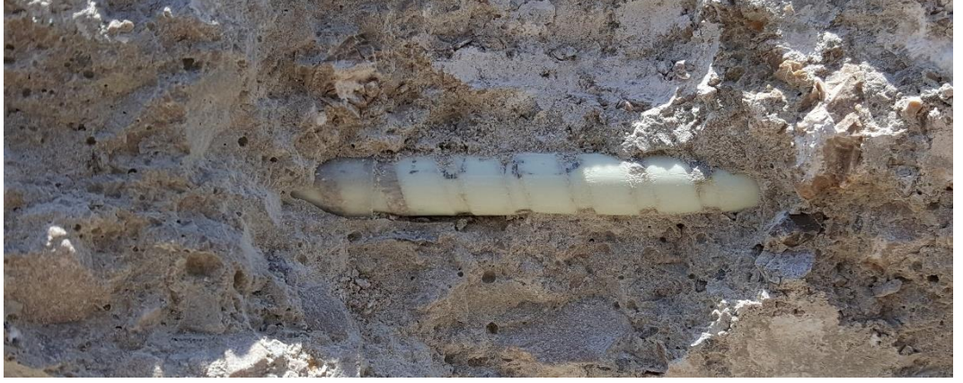
Şekil A.11. Oluklu GFRP (GWO) donatının betondan sıyrılması sonrası yüzeyindeki deformasyon
