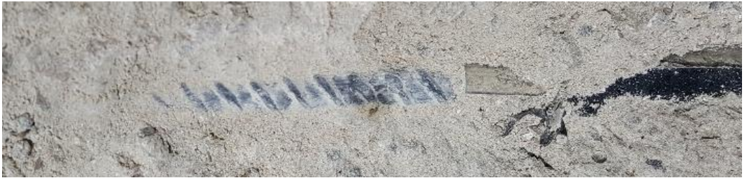
Şekil A.13. Nervürlü betonarme çelik (SR) donatının betondan sıyrılma sonrası yüzeyindeki deformasyon
