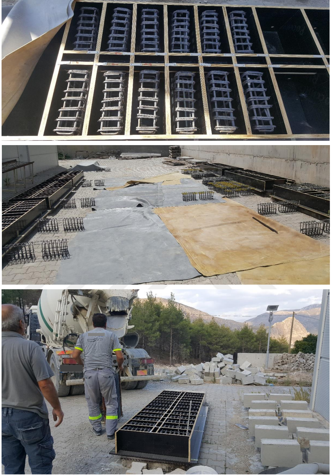
Şekil A.4. Deney kiriş donatılarının kalıplara yerleştirilmesi ve beton dökümü
