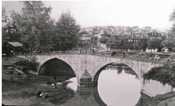
Şekil 33. Kemer Köprü (Eski)
